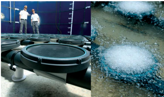
Obr. 9 Diskový element iDISC společnosti INVENT [16]
