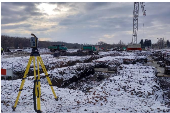
Obrázek 14 - Pohled na staveniště s hotovými pilotami
