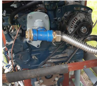
Obrázek 48: Upravené napojení vstupního potrubí do motoru
