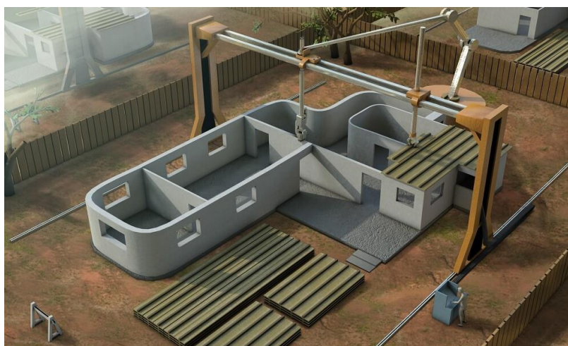
obr. č. 7: Princip výroby skeletu domu pomocí Contour Creating
