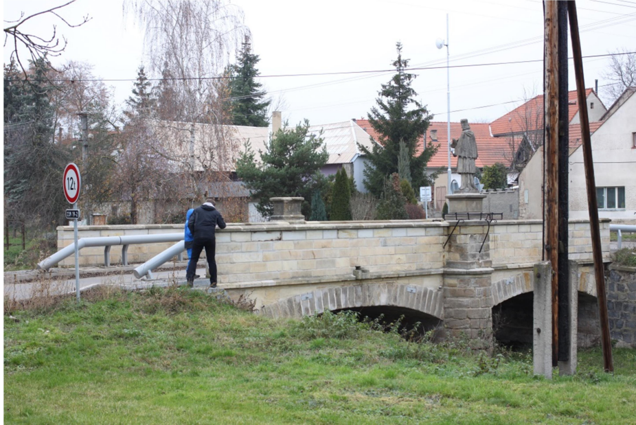
Obr. 22. Fotografie z průběhu zaměřování mostu v obci Tmář
