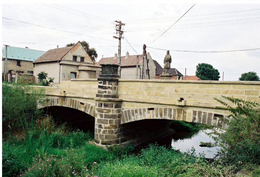
Obr. 5. Kamenný most v obci Tmář [8]
