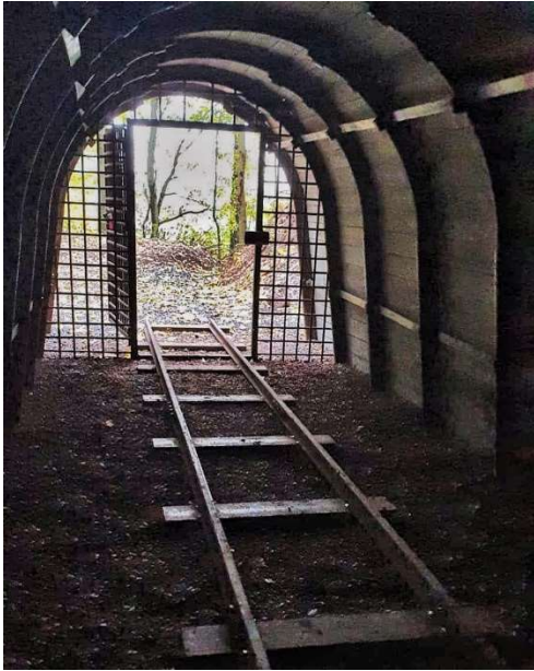
Obr. 4 – Opravená část pracovní štoly [vlastní zdroj]
