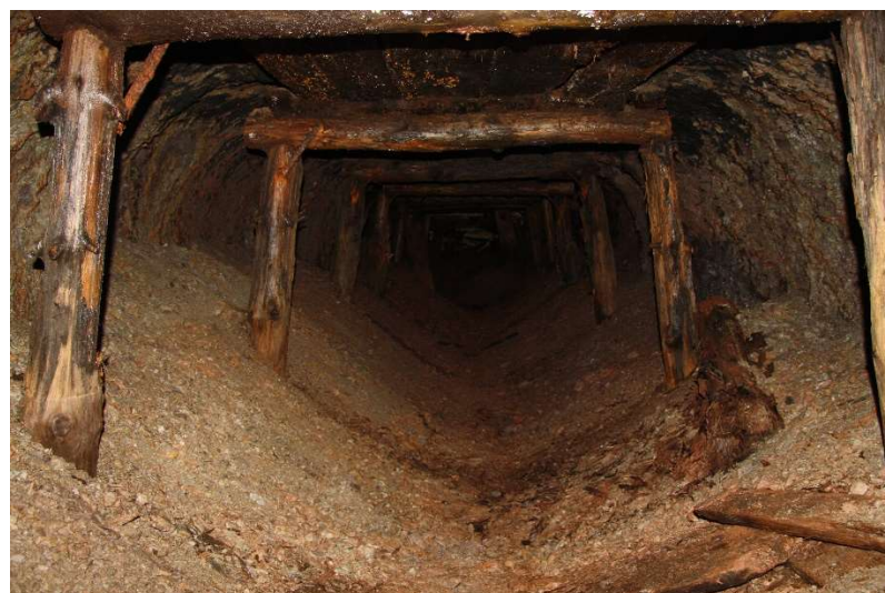
Obr. 7 – Pracovní štola se starou výztuží [vlastní zdroj]
