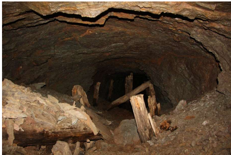
Obr. 6 – Neopravená část štoly bez staré výztuže [vlastní zdroj]
