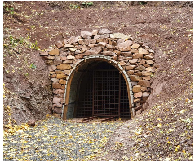
Obr. 5 – Opravený vstup do pracovní štoly [vlastní zdroj]
