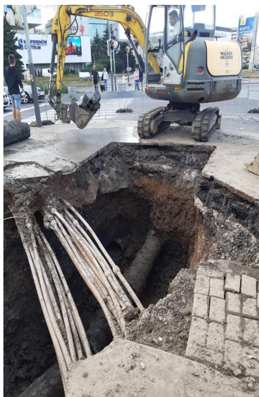
Obr. 9 Obnažené chráničky s optickými kabely
