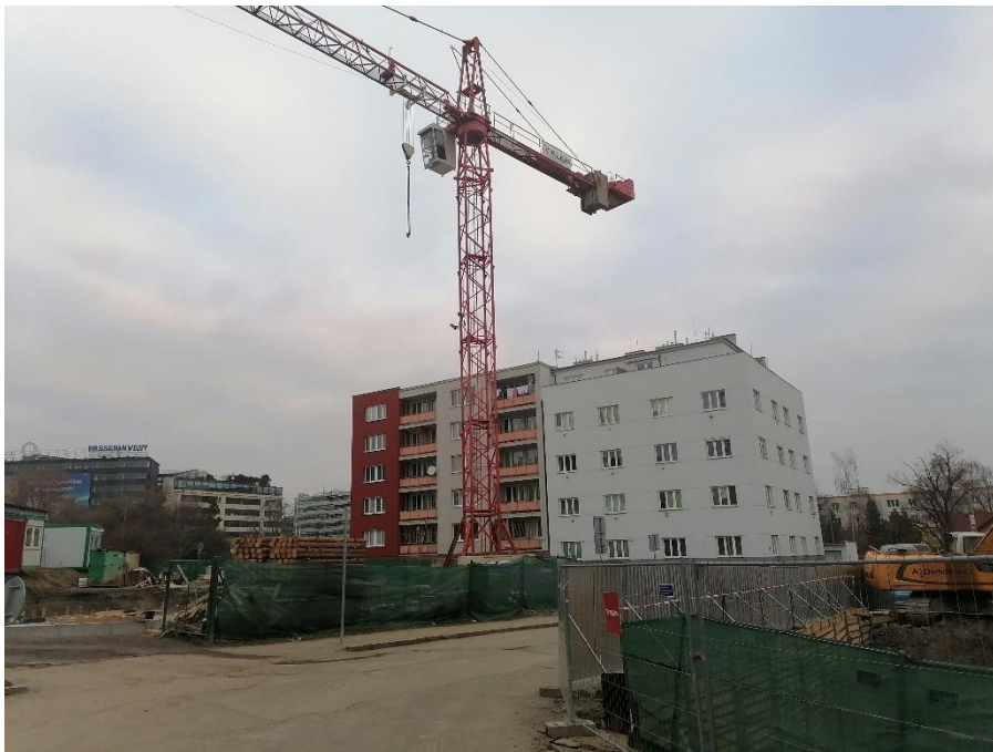
Obr. 16 Staveniště na Kačerově
