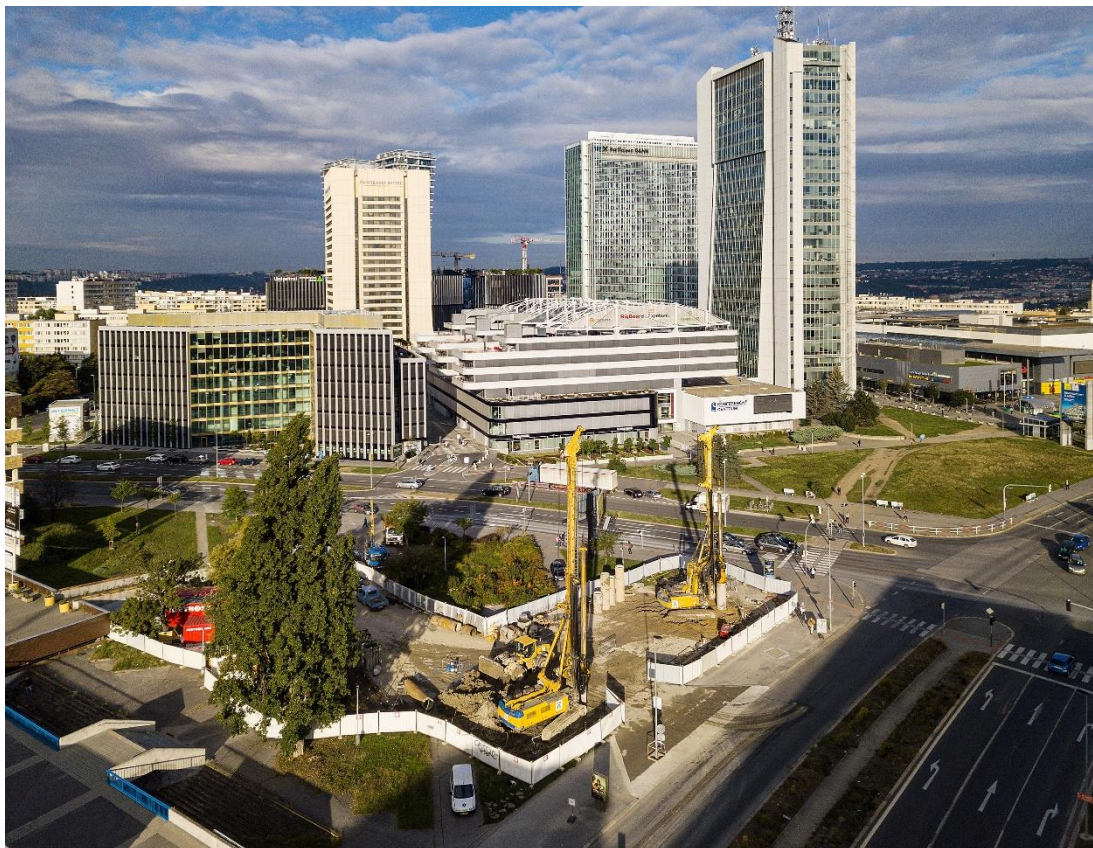
Obr. 7 Staveniště PAD1 Pankrác
