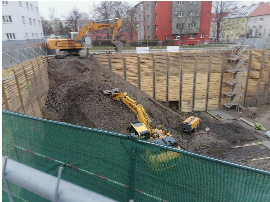
Obr. 17 Staveniště na Kačervě – stavební jáma
