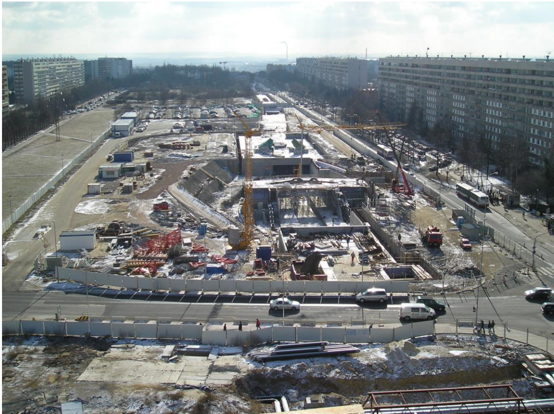
Obrázek 1 – Staveniště stanice metra Střížkov
