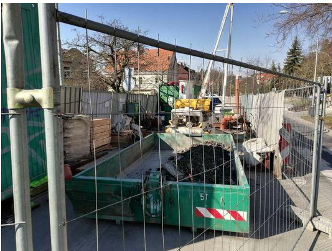
Obr. 19 Staveniště v ulici Holečkova
