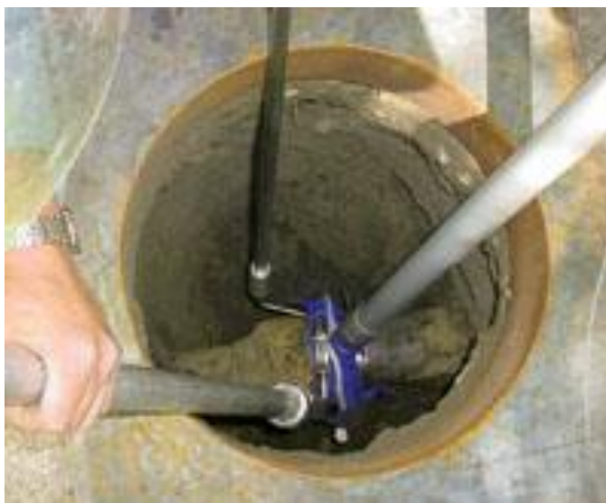
Obr. 22 Příklad minimalizace zásahu do povrchu komunikace ve veřejném prostoru sídla při realizaci přípojkového vedení ze stávajícího ličnického potrubního řadu technologií KEYHOLE Zdroj: [9]
