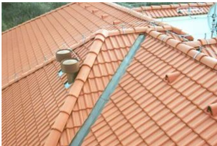
Obrázek 18: Detail úžlabí [21]
