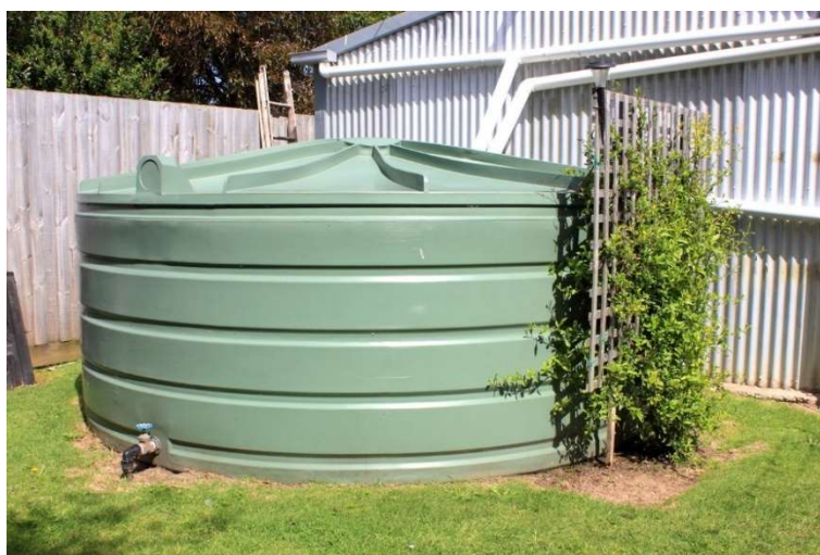
Obrázek č.16 – Nadzemní akumulční nádrž [32]
