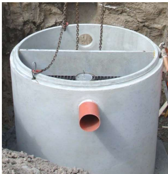
Obrázek č.18 – Betonová válcová nádrž [35]
