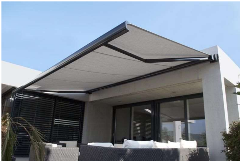
Obrázek 3: Markýza na RD (Stínící technika Kozák, nedatováno)
