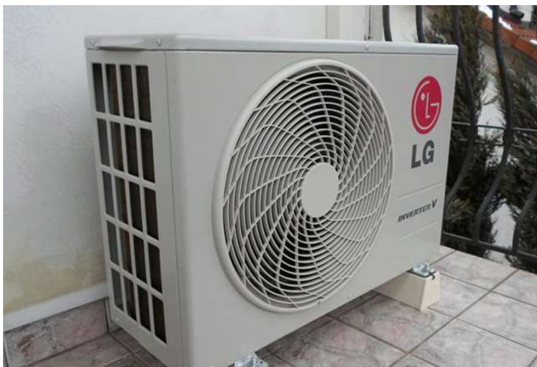
Obrázek 12: Venkovní jednotka multi-split klimatizace, umístěná na podstavci vedle fasády (Levná montáž klimatizace, nedatováno)
