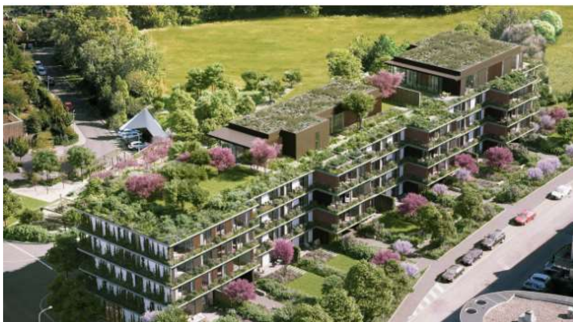
Obrázek 8: Zelená střecha na bytovém domě (Marečková, 2018)
