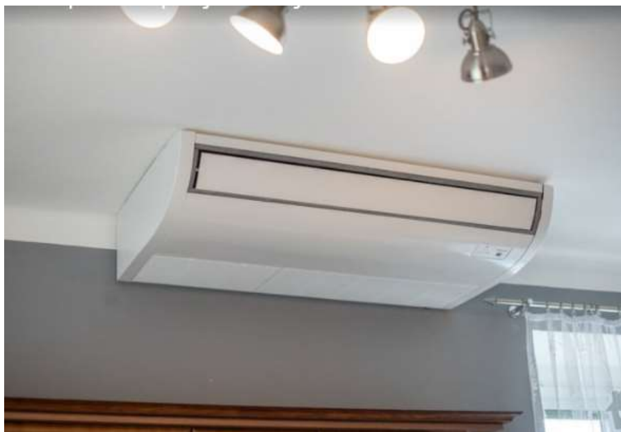
Obrázek 15: Podstropní vnitřní split jednotka (NejŘemeslníci, nedatováno)
