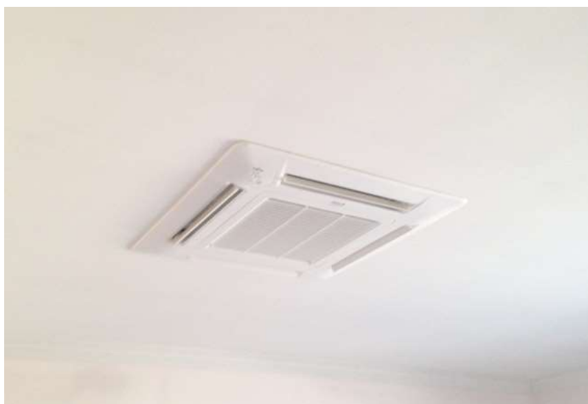
Obrázek 16: Kazetová vnitřní splitová jednotka (Levná montáž klimatizace, nedatováno)
