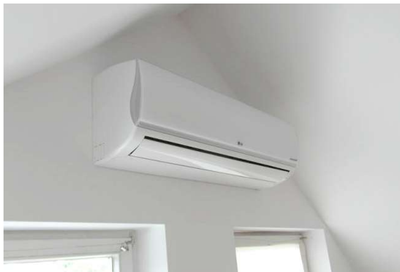
Obrázek 13: Nástěnná vnitřní split jednotka (Levná montáž klimatizace, nedatováno)
