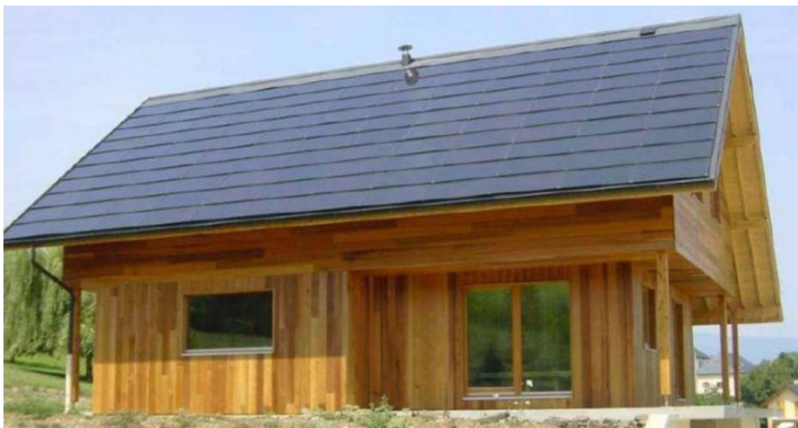
Obrázek 21 Příklad použití tenkovrstvé FV na dřevostavbě [34]
