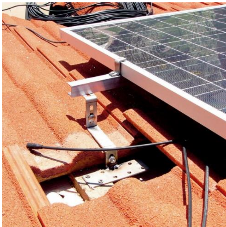
Obrázek 15 Instalace FV panelů na šikmou střechu [24]
