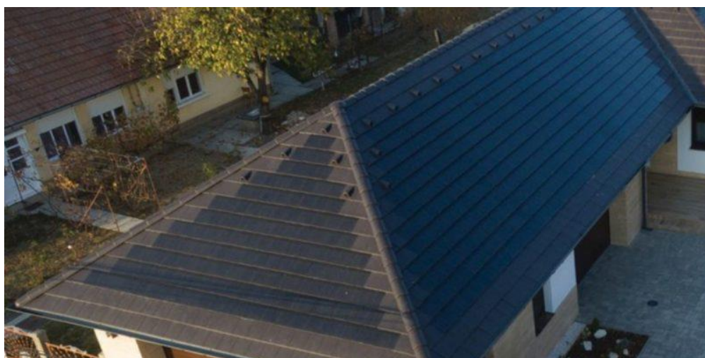
Obrázek 18 Střecha s krytinou Terran Generon [29]
