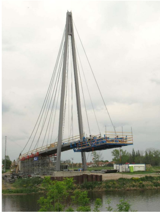
Obrázek 60 Letmá montáž s využitím montážního vozíku [21]
