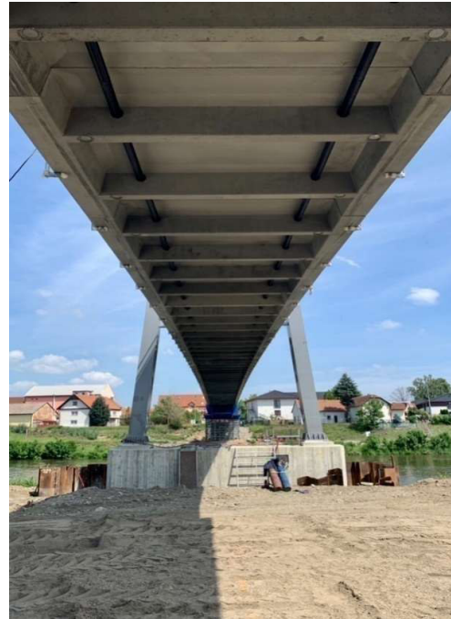
Obrázek 61 Pohled na vedení vnějšího předpětí mostovky [22]
