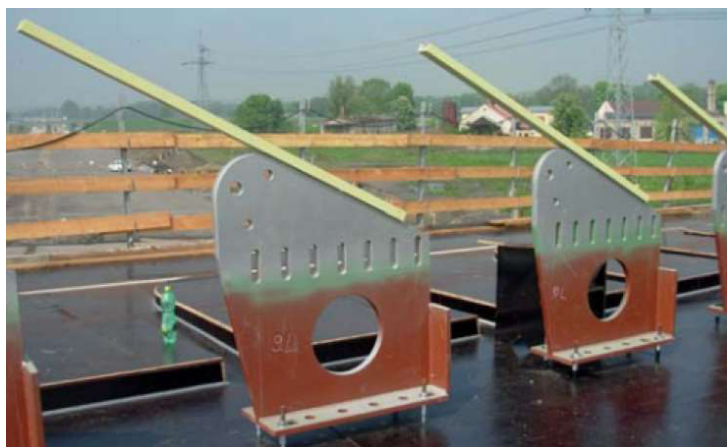
Obrázek 69 Ocelový přípravek pro kotvení závěsů do mostovky [25]
