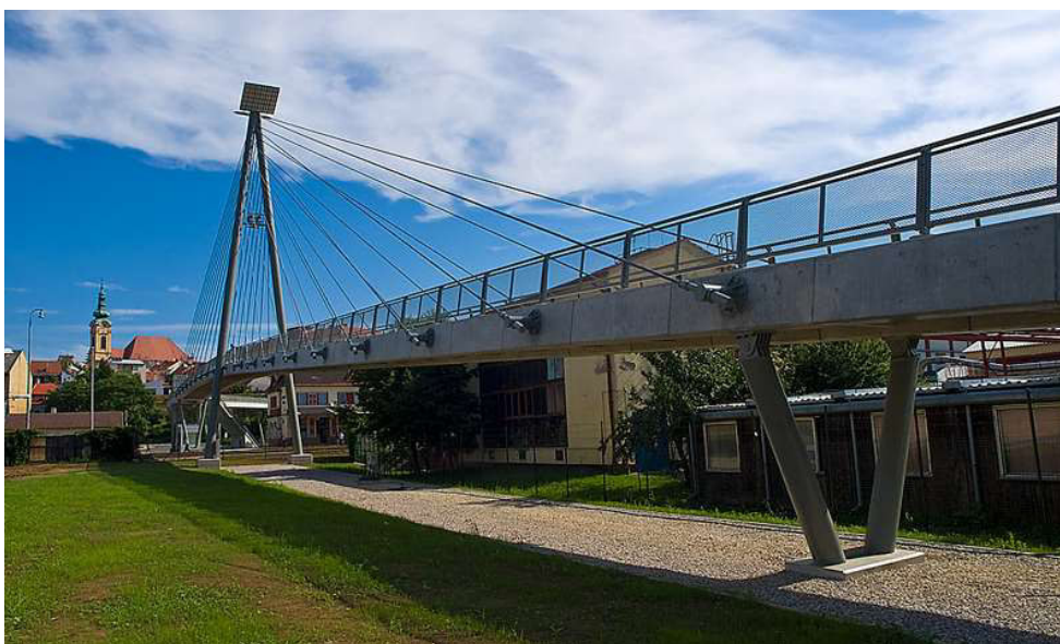
Obrázek 65 Lávka v Uherském Brodě, pole vedené mezi okolní zástavbou [24]
