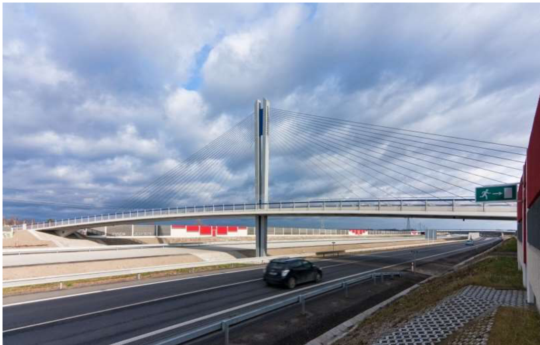
Obrázek 71 Lávka přes dálnici D1 v Bohumíně [25]
