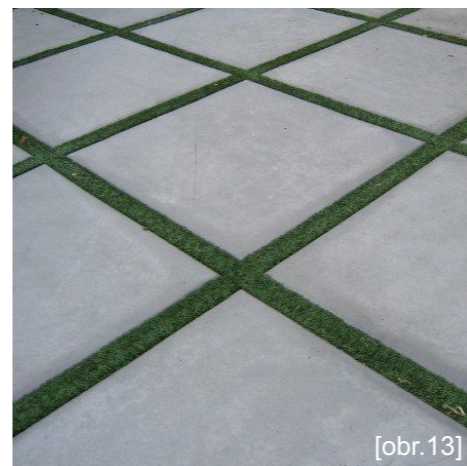
P05 Velkoformátová zatravnovací dlažba beton, barva šedá, podobná RAL 7035, 100 x 100 cm
