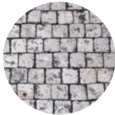
Pražská mozaika světlá P2 Malé mramorové kostky použity ve světlé barevné variantě. Kladeny řádkově (viz. obrázek) do písku. Tvoří pochozí plochy tramvajových nástupišť.
