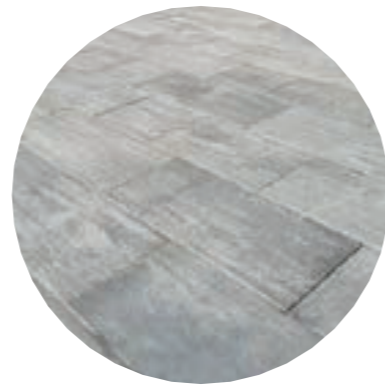
Velkoformátová betonová dlažba P7 Velkoformátová betonová dlažba přírodní barvy. Dlážděny řádkově (viz. obrázek) do drceného kameniva drobné frakce. Tvoří pochozí plochy veřejných prostranství při vodních prvcích a v ose nádražních objektů.
