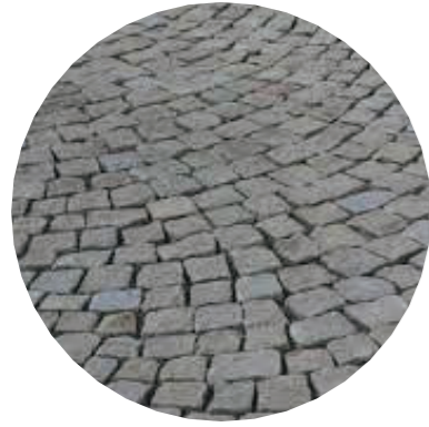
Velká žulová kostka (vlaštovka) P4 Velké žulové kostky použity ve své přírodní barvě. Dlážděny vlaštkou (viz. obrázek) do drceného kameniva drobné frakce. Tvoří pojízdné plochy zklidněných komunikací a příležitostného parkování.
