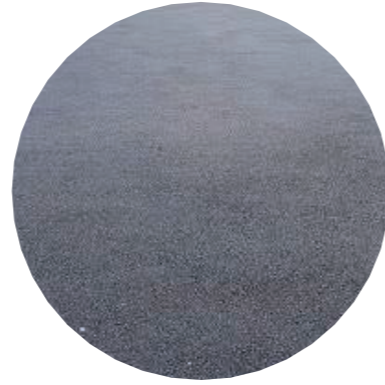
Tmavý asfalt P8 Tmavý asfaltový povrch přírodní barvy. Tvoří pojízdné plochy vozovek.
