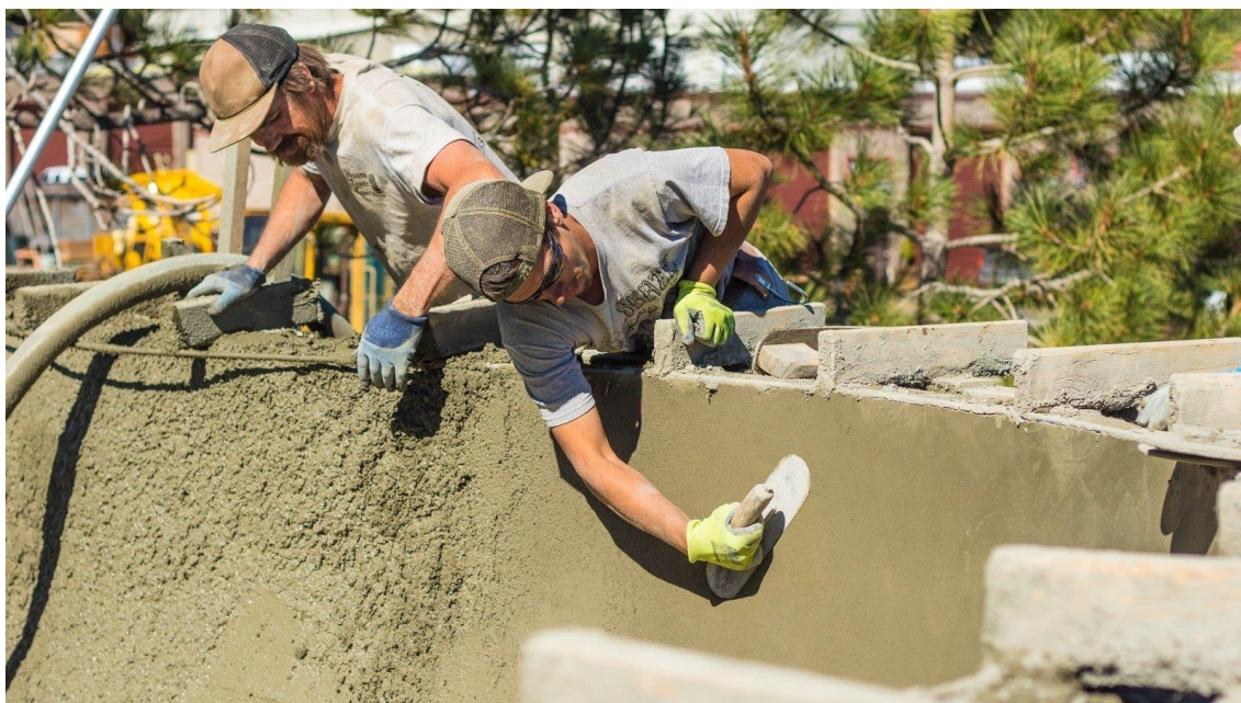
Obr. 17 Finální úprava povrchu betonu pomocí ručních hladítek 21
