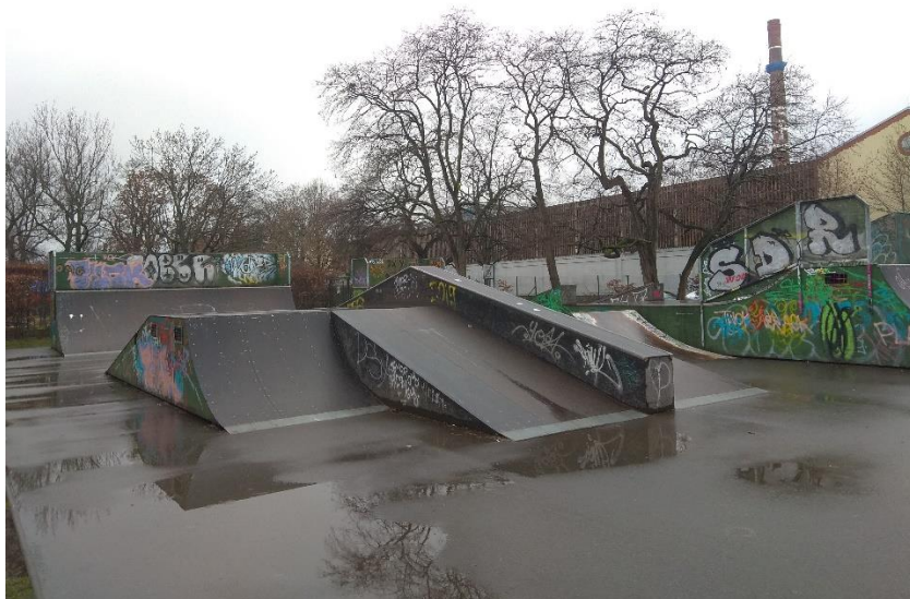
Obr. 2 Skatepark Smíchov, Praha; obnovený v roce 2015; asfaltový povrch, překážky s ocelovou konstrukcí a povrchem z překližky
