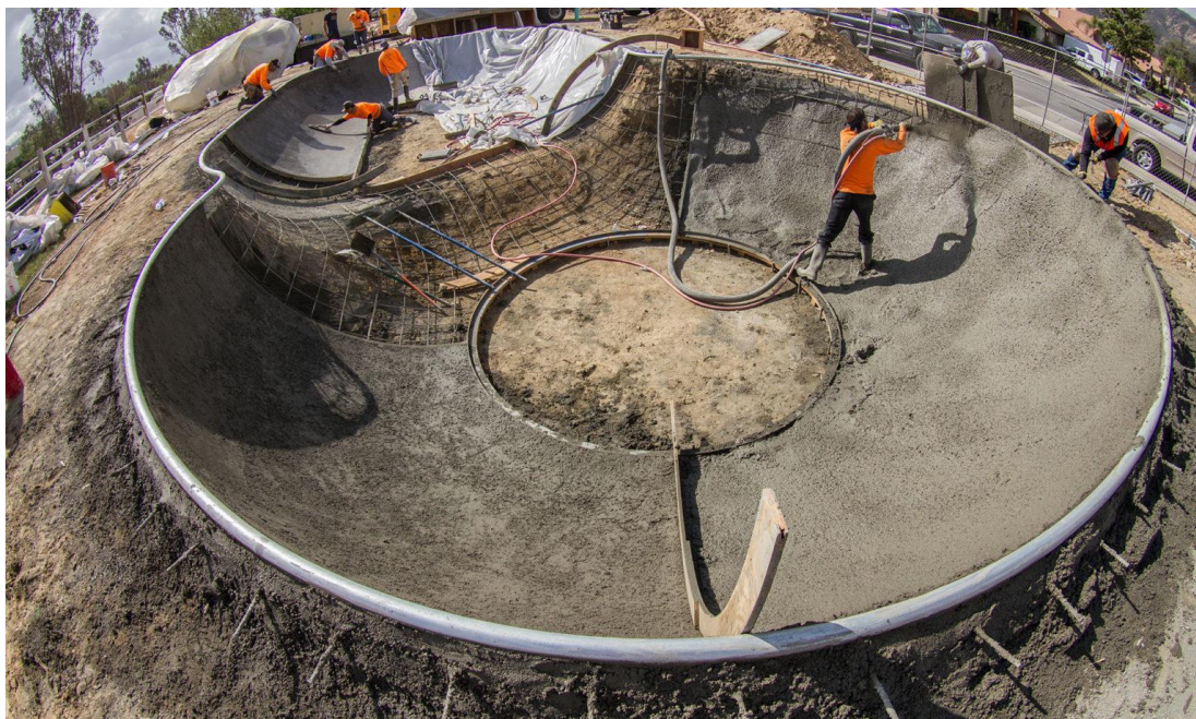
Obr. 16 Výstavba bazénu pomocí technologie stříkaného betonu 20
