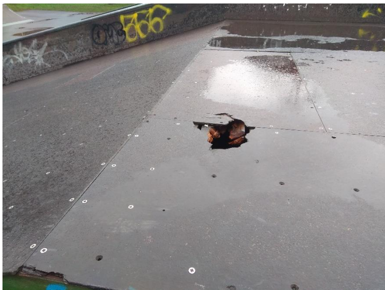
Obr. 3 Skatepark Smíchov, Praha; proražený povrch z překližky
