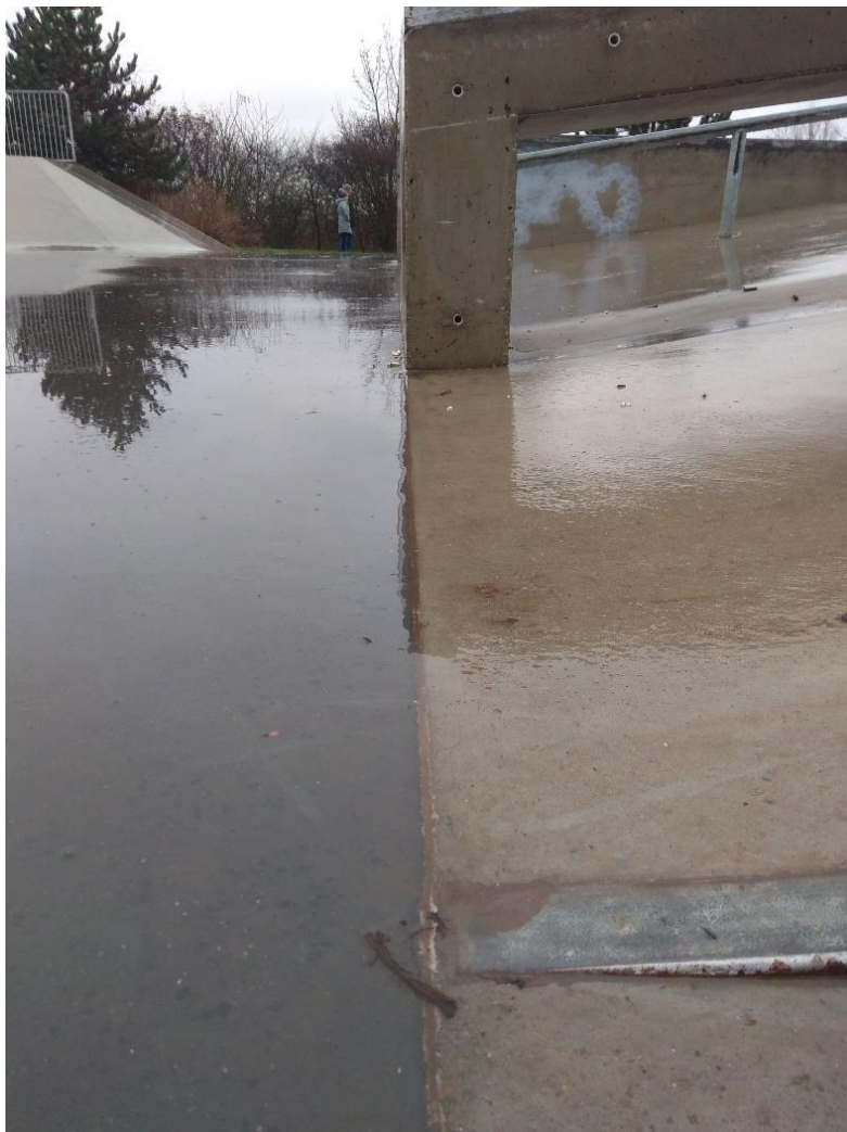
Obr. 8 Skatepark Černý Most, Praha; dokonale hladký nájezd na překážku
