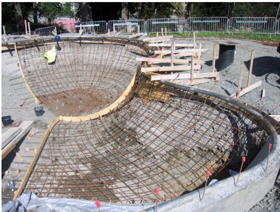
Obr. 14 Konstrukce překážky před betonáží 18
