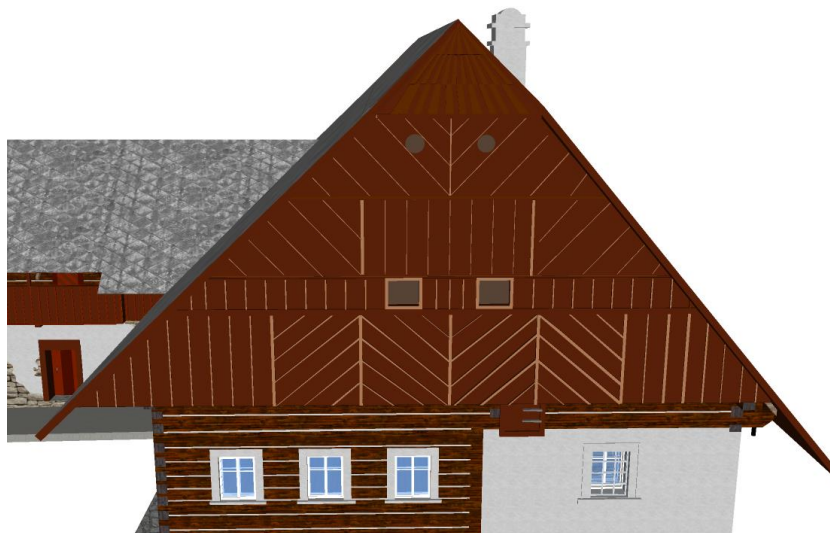
Obr. 21: Hlavní část stavení – lomenice
