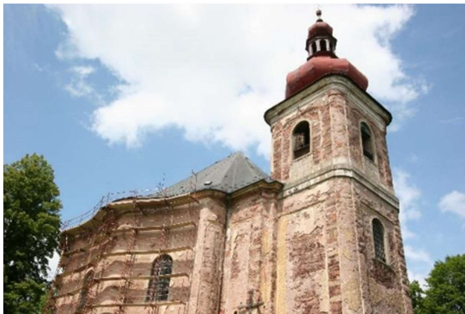
Obr 10. Ukázka rekonstrukce kostela Všech svatých a věž (zdroj: archiv FSv, k155)
