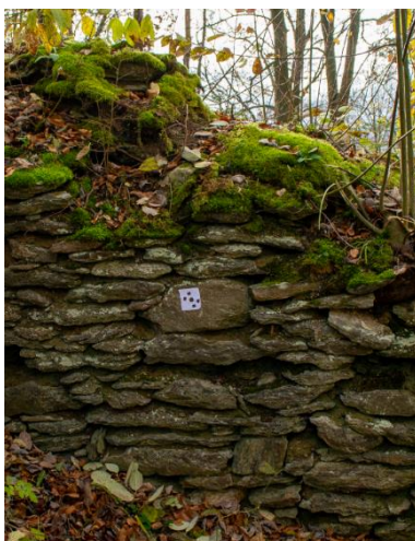
Obr.25: Ukázka signalizace vřícovacích bodů.
