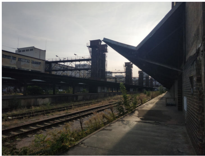
BUDOVA BÝVALÉHO NÁKLADOVÉHO NÁDRAŽÍ
