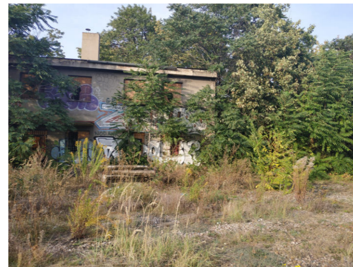
NEVYHOVUJÍCÍ ZÁSTAVBA NA VÝCHODĚ LOKALITY
