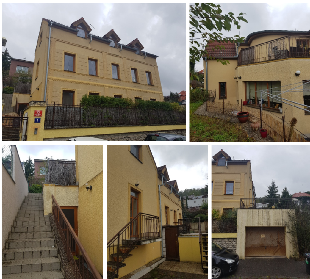
Obr. 1.3: Fotodokumentace stávajícího objektu - exteriér
