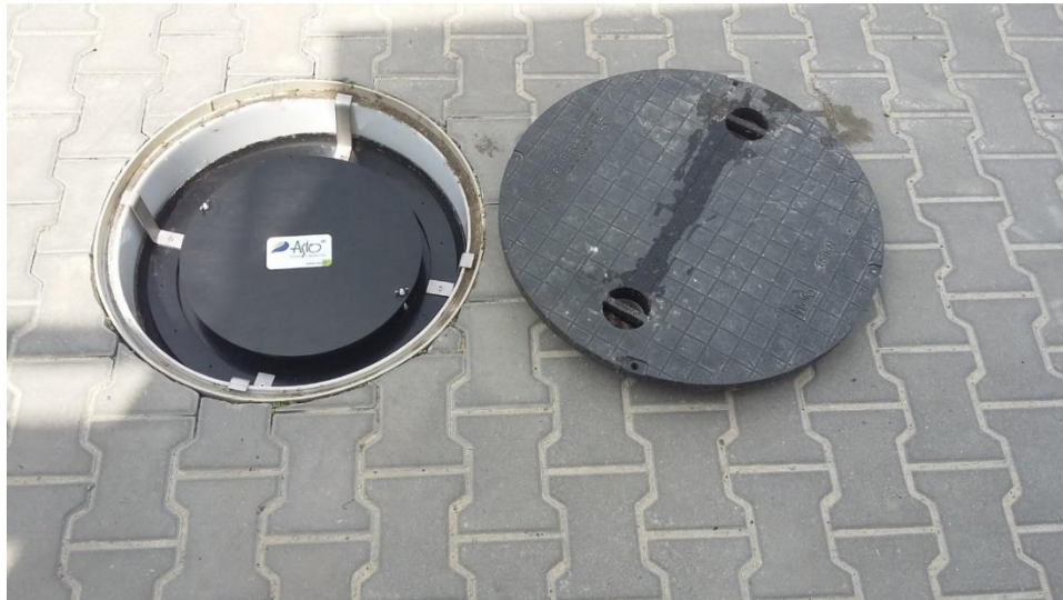
Obrázek 8: Sorpční filtr pro snížení zápachu firmy Asio s.r.o. v uklidňovací šachtě [16]
