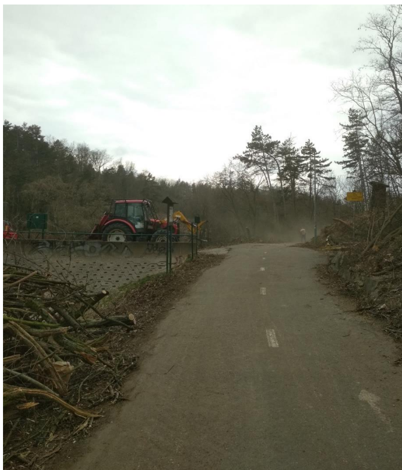
2.2. Příprava pro výstavbu bezpečnostního přelivu, foto: Lenka Langhammerová, 23. 3. 2021
