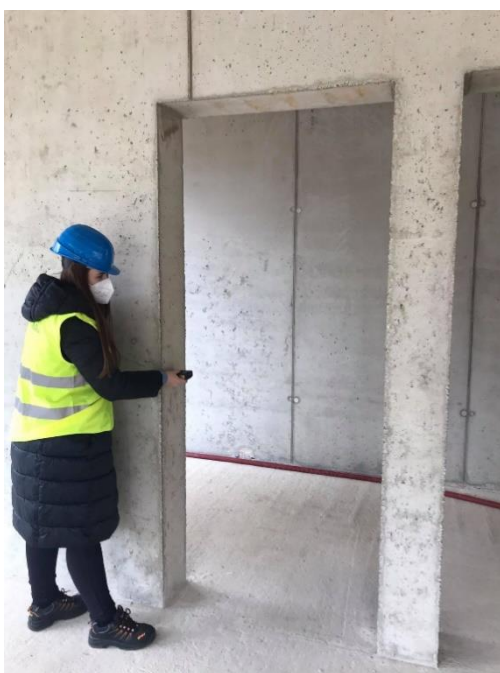
Obrázek 38 - Kontrola rozměrů stavebního otvoru ve vodorovném směru 1.NP – archiv autora
