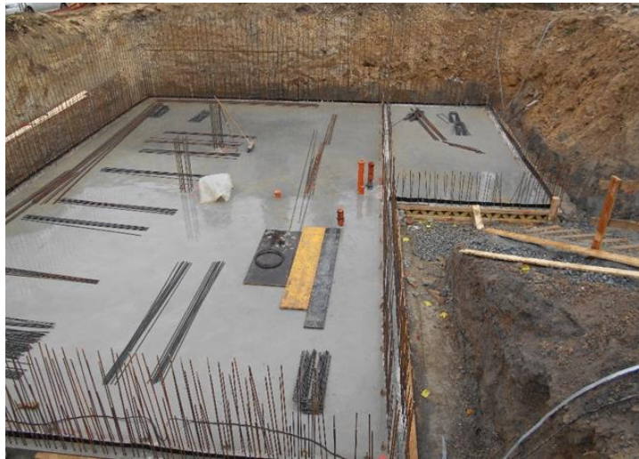
Obrázek 28 – Ošetřování betonu + rozdělení výztuže dle druhu a místa uložení – archiv autora
