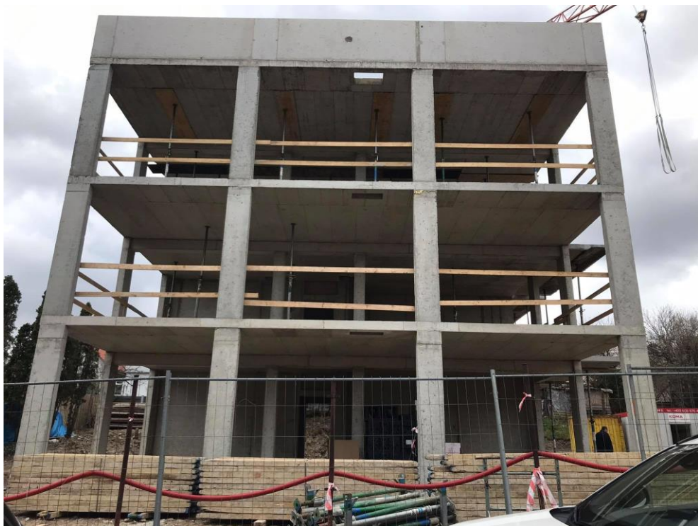
Obrázek 49 - Dokončená ŽB monolitická konstrukce – archiv autora
