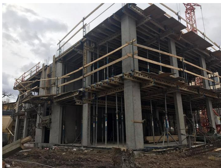
Obrázek 31 – Bednění stropní konstrukce nad 2. NP – archiv autora
