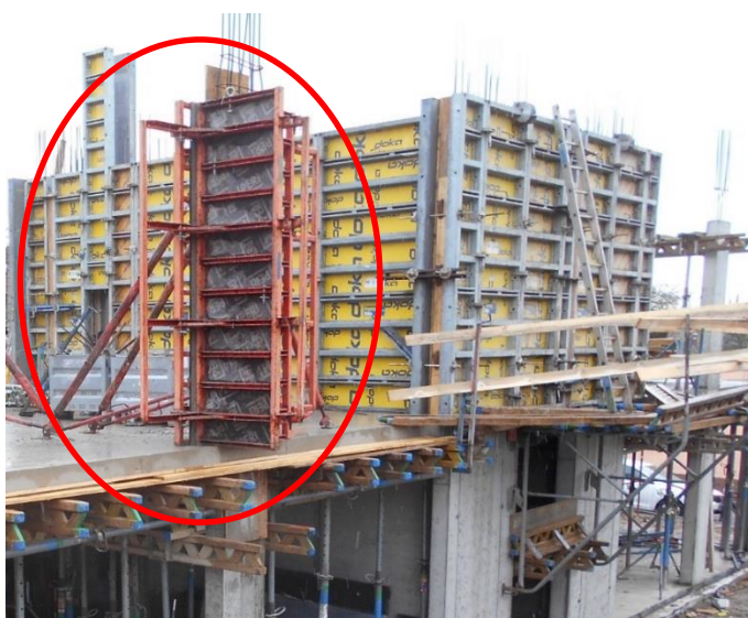
Obrázek 23 – Výztuž + bednění + stabilizace sloupu – archiv autora
