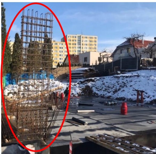
Obrázek 19 – Výztuž obdélníkového sloupu před montáží bednění – archiv autora
