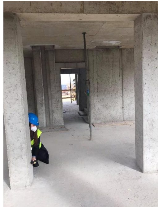
Obrázek 41 - Kontrola vzdálenosti protilehlých svislých konstrukcí 3.NP – archiv autora
