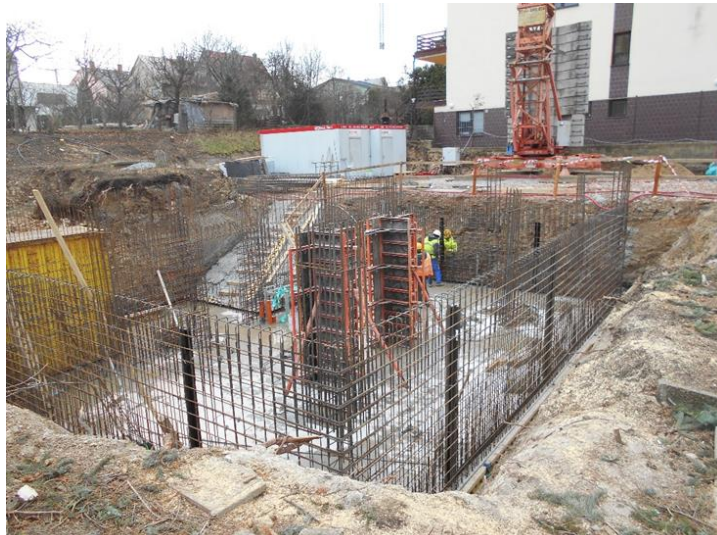
Obrázek 29 – Vázání výztuže stěn + bednění sloupů 1. PP – archiv autora
