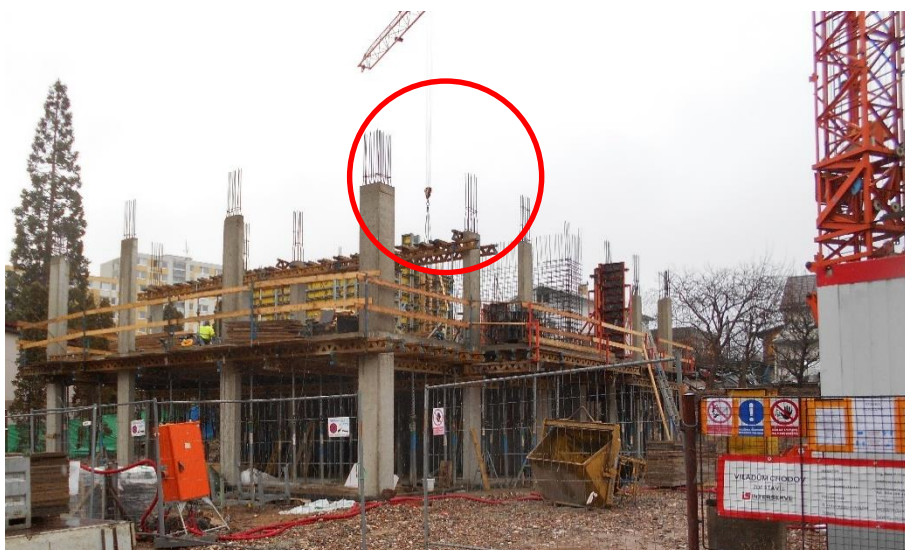
Obrázek 21 – Vyčnívající kotevní pruty výztuže nad 2.NP – archiv autora
