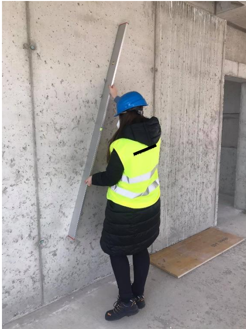
Obrázek 44 - Kontrola místní rovinnosti svislé konstrukce 1.NP – archiv autora
