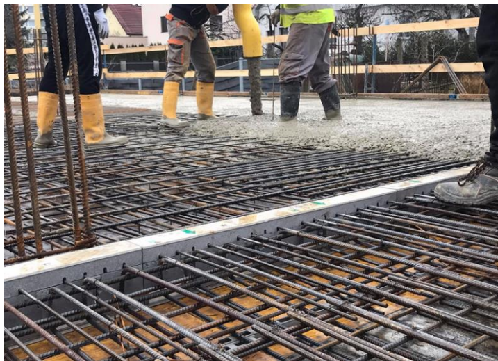
Obrázek 30 – Betonáž stropu nad 1. NP – archiv autora
