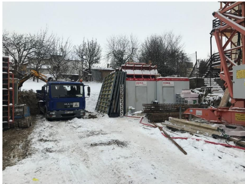
Obrázek 16 – Zařízení staveniště – archiv autora
