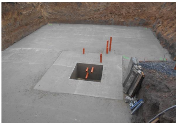
Obrázek 26 – Podkladní beton + prostupy – archiv autora
