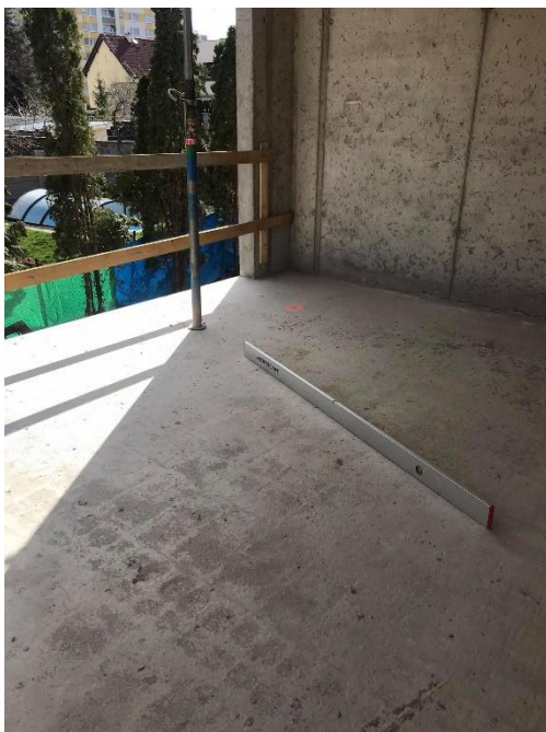
Obrázek 42 - Kontrola místní rovinnosti vodorovné konstrukce 2.NP – archiv autora
