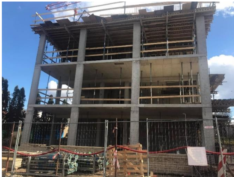
Obrázek 24 – Provedené, odbedněné sloupy – archiv autora
