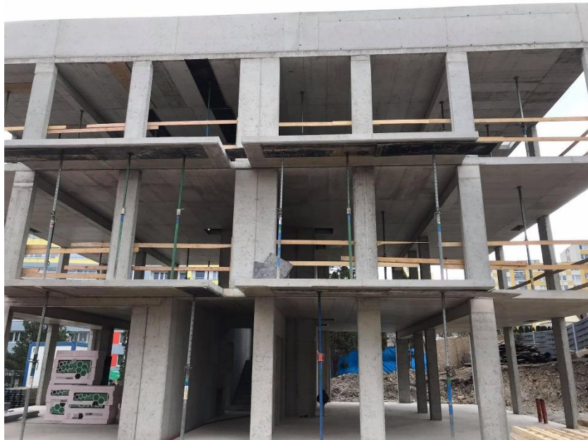
Obrázek 48 - Dokončená ŽB monolitická konstrukce – archiv autora
