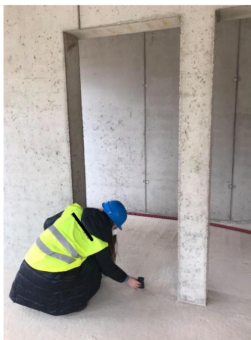
Obrázek 39 - Kontrola rozměrů stavebního otvoru ve svislém směru 1.NP – archiv autora
