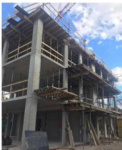
Obrázek 32 – Bednění stropní konstrukce nad 3. NP + bednění balkónů – archiv autora
