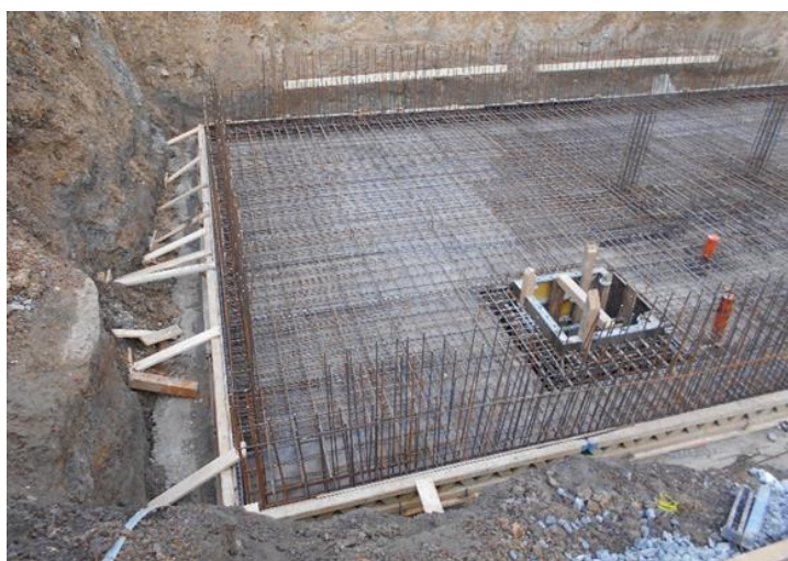
Obrázek 27 – Bednění + výztuž základové desky – archiv autora
