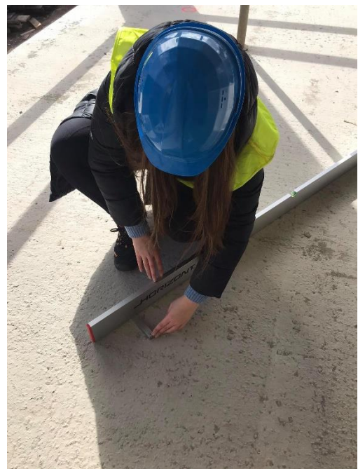
Obrázek 43 - Kontrola místní rovinnosti vodorovné konstrukce 3.NP – archiv autora
