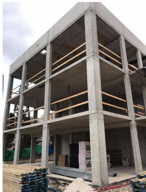
Obrázek 47 - Dokončená ŽB monolitická konstrukce – archiv autora
