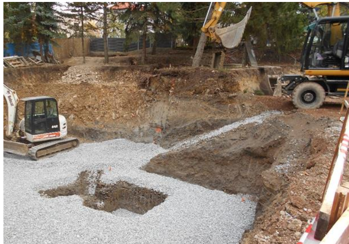
Obrázek 25 – Štěrkový podklad + mechanizace – archiv autora
