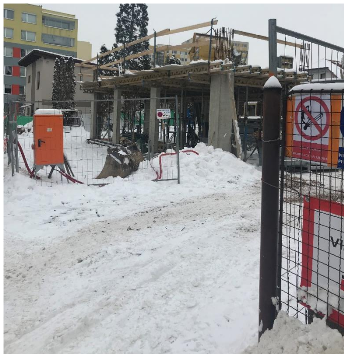
Obrázek 17 – Vjezd na staveniště – archiv autora
