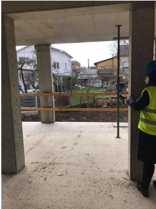
Obrázek 40 - Kontrola vzdálenosti protilehlých svislých konstrukcí 2.NP – archiv autora
