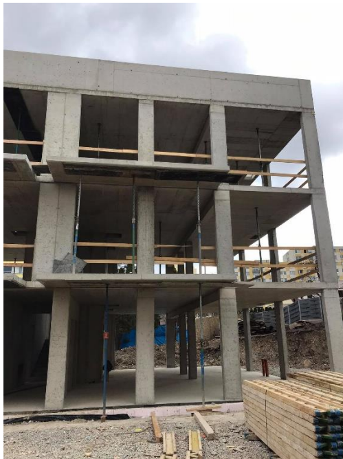
Obrázek 46 - Dokončená ŽB monolitická konstrukce – archiv autora
