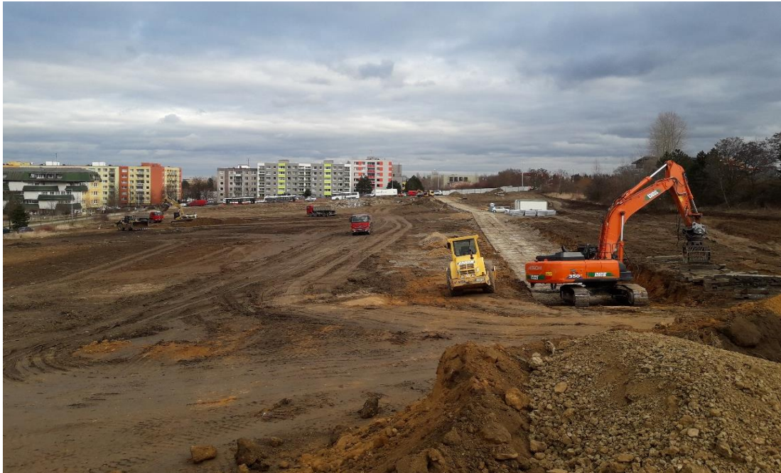
Obr. č. 33 Realizace panelové vnitro staveništní komunikace a zahájení výkopových prací na Bloku 1
