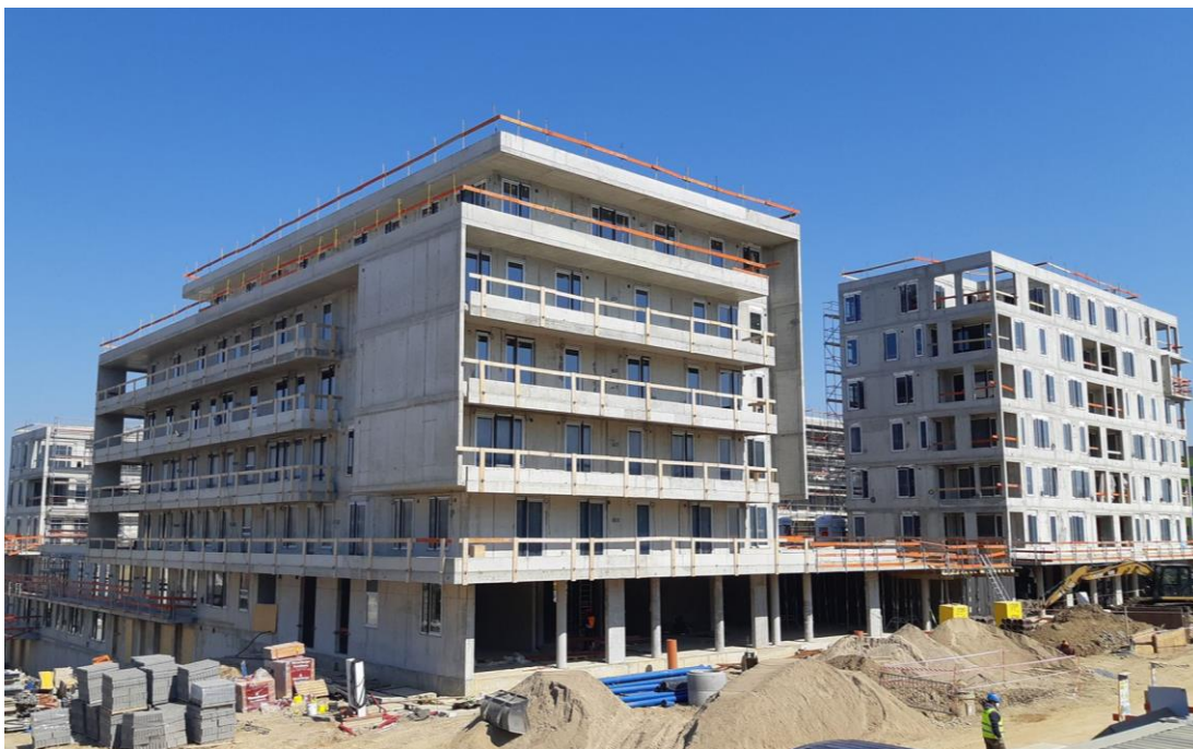
Obr. č. 40 Dokončená hrubá vrchní stavba Bloku 1
