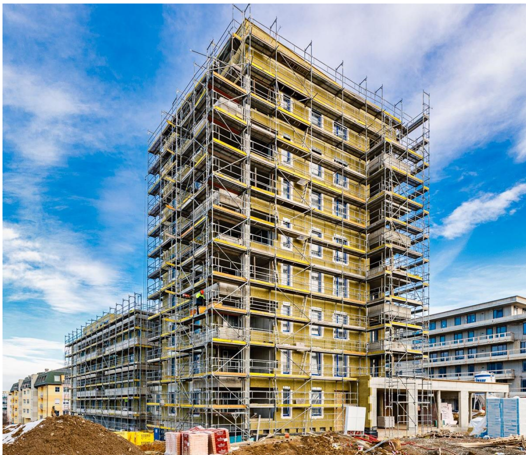
Obr. č. 43 Realizace fasád na Bloku 2
