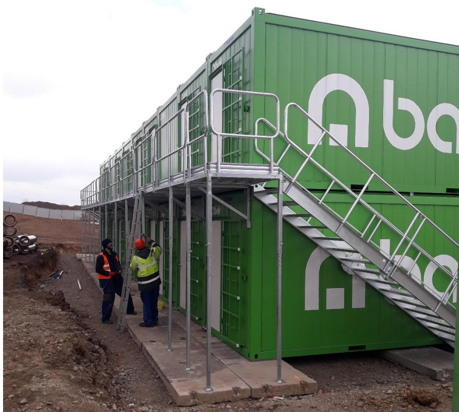
Obr. č. 47 Realizace ochozu a schodiště pro buňky v druhém patře
