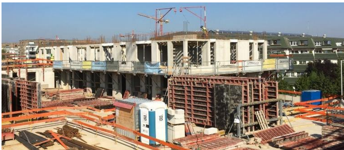
Obr. č. 17 Mobilní WC umístěné na stavbě při realizaci hrubé vrchní stavby
