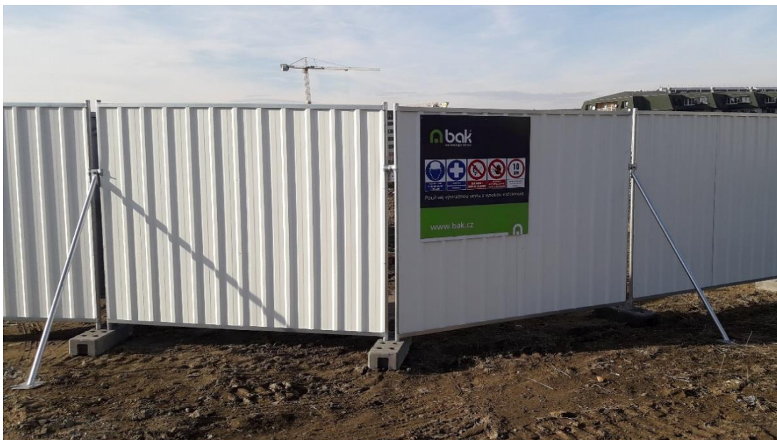
Obr. č. 19 Oplocení na staveništi
