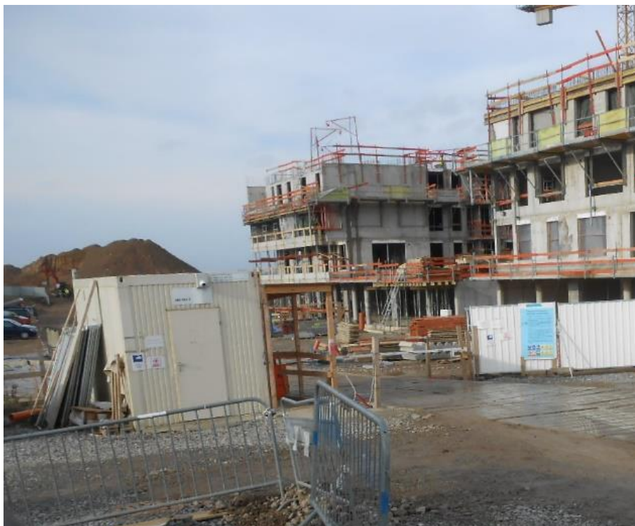
Obr. č. 20 Vstup na staveniště
