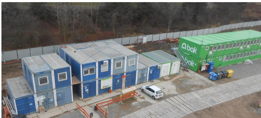
Obr. č. 18 Pohled na buňkoviště - vpravo hlavní dodavatele stavby, vlevo subdodavatel monolitické konstrukce
