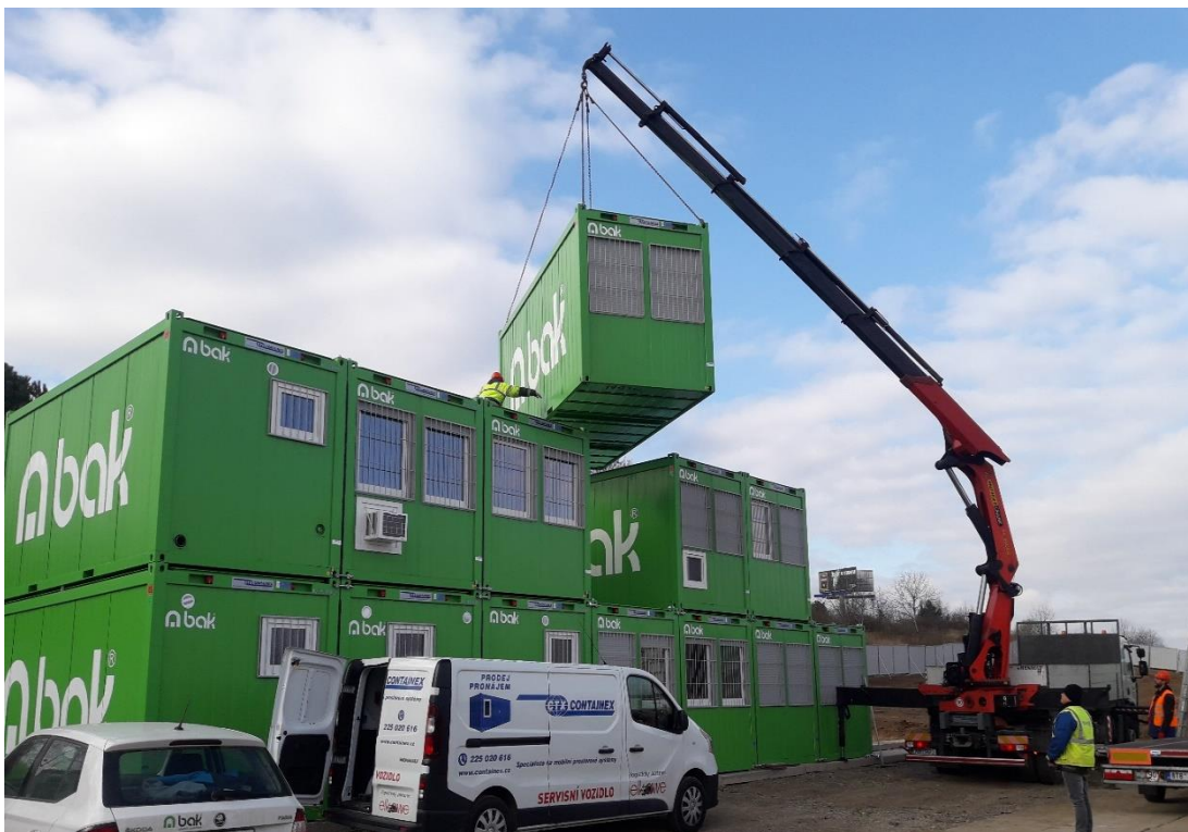
Obr. č.46 Pokládka buněk pomocí autojeřábu
