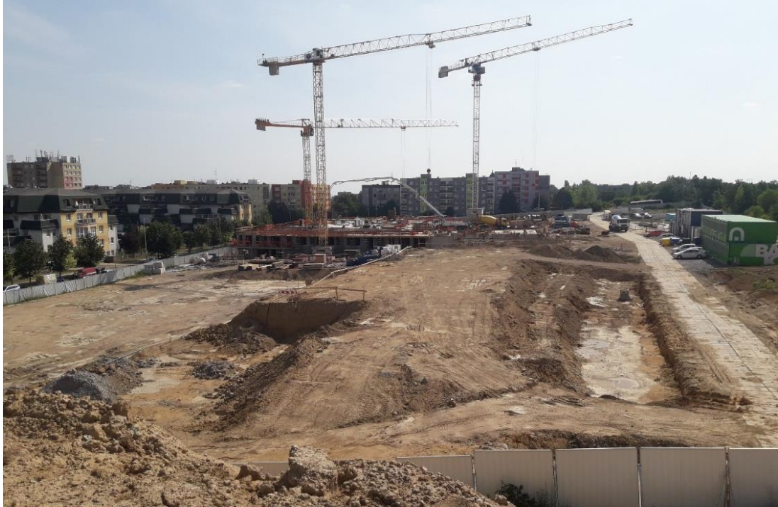
Obr. č. 35 Blok 1 realizace hrubé stavby, Blok 2 pozastavené práce po dokončení pilot a zemních prací.
