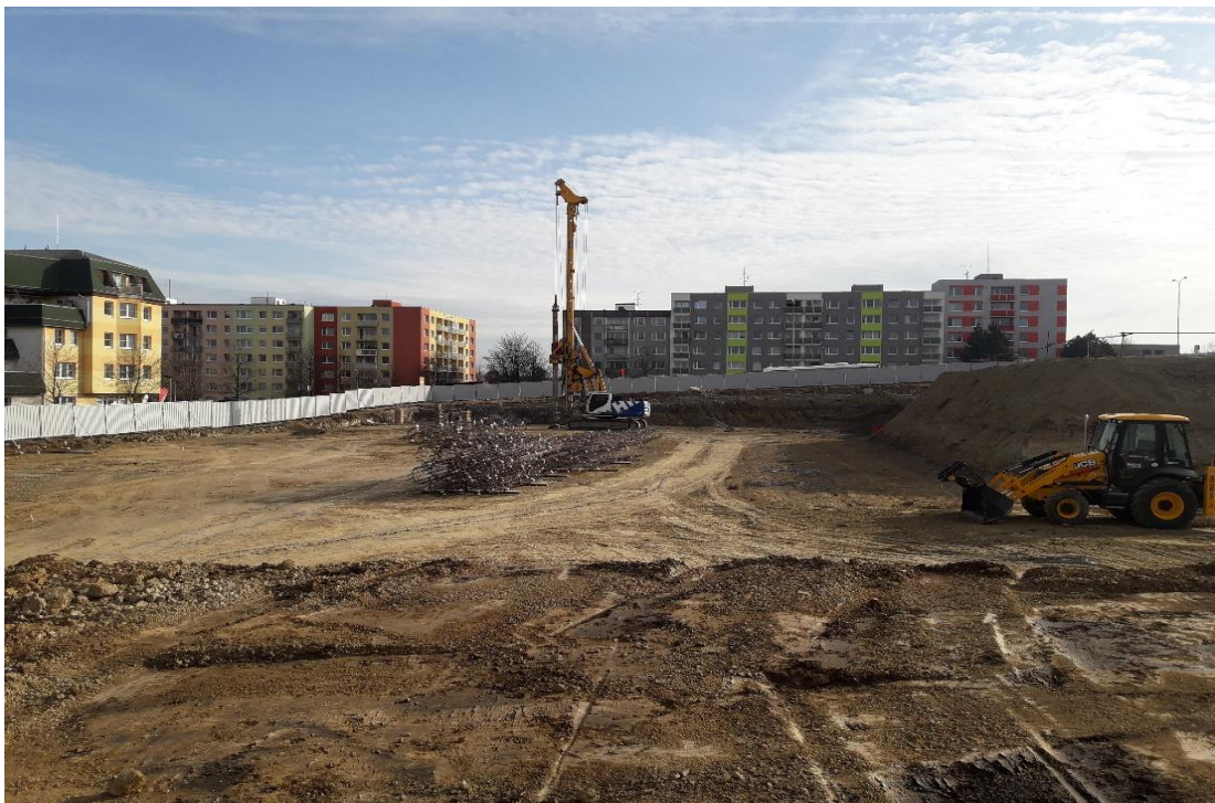
Obr. č. 34 Realizace pilot na Bloku 1
