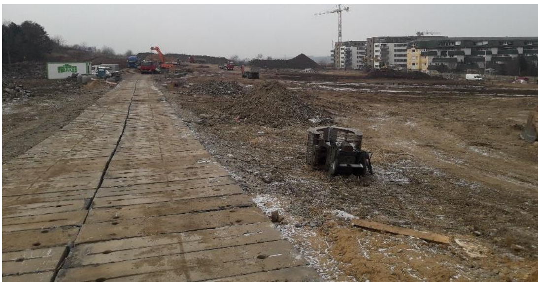
Obr. č. 9 Staveništní komunikace ze železobetonových panelů (zdroj vlastní)
