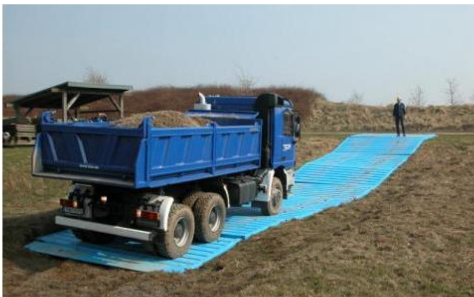
Obr. č. 7 Staveništní komunikace z ocelových panelů (13)
