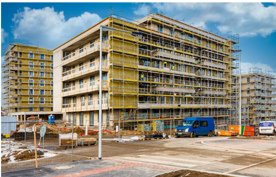
Obr. č. 44 Pohled na východní stranu Bloku 2 včetně nově zrealizované komunikace
