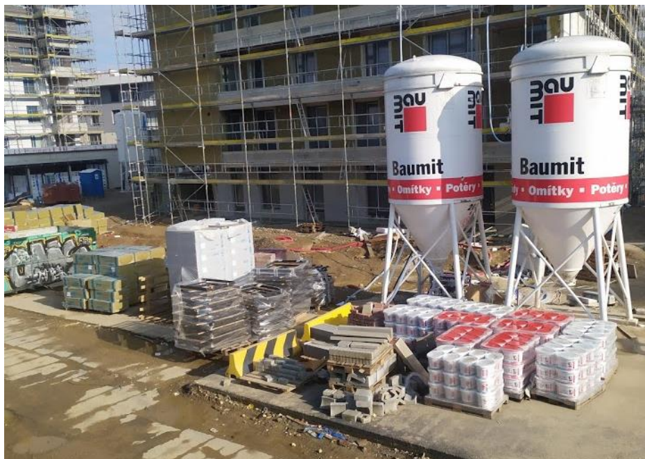
Obr. č. 29 Umístění sila pro omítkovou směs a skladování materiálu
