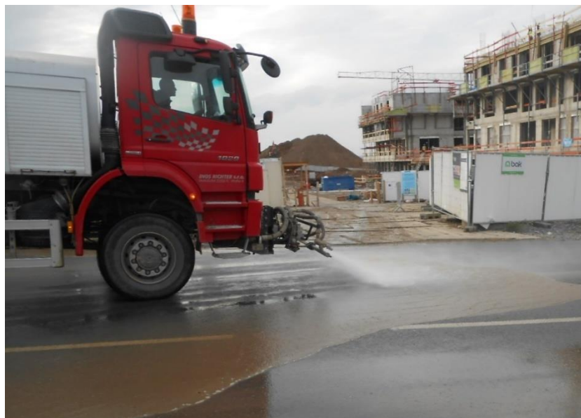
Obr. č. 28 Čištění komunikace
