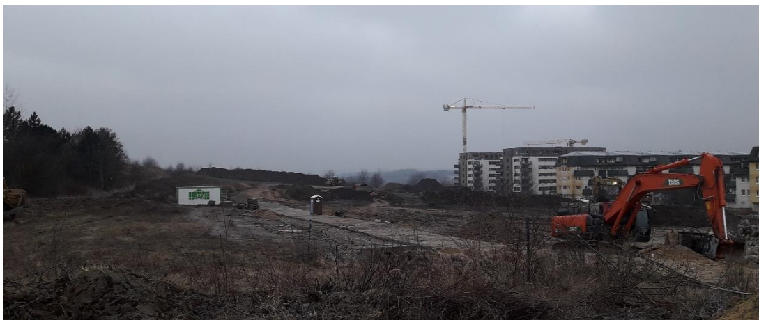
Obr. č. 32 Pohled na zařízení staveniště při zahájení zemních prací
