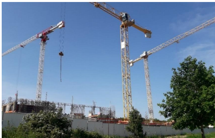
Obr. č. 30 Věžové jeřáby na staveništi
