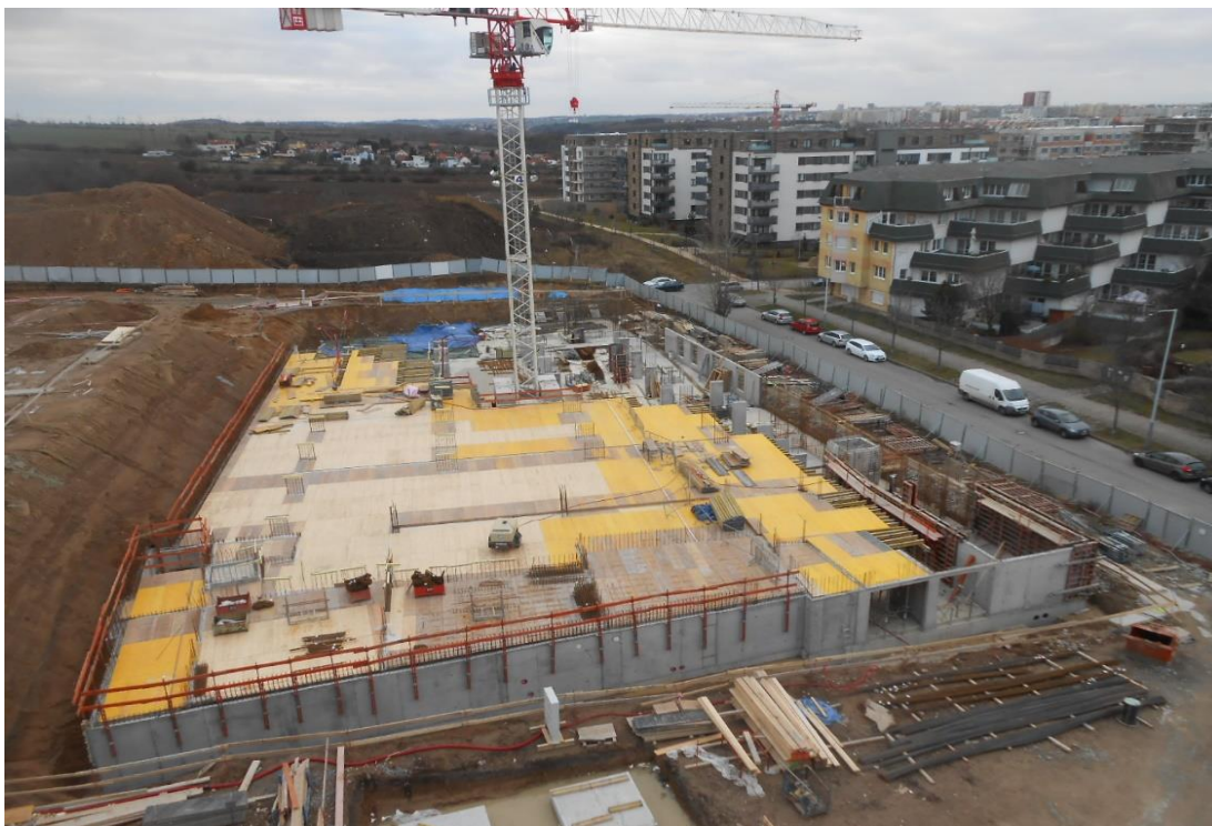
Obr. č.38 Hrubá stavba podzemního podlaží na Bloku 2
