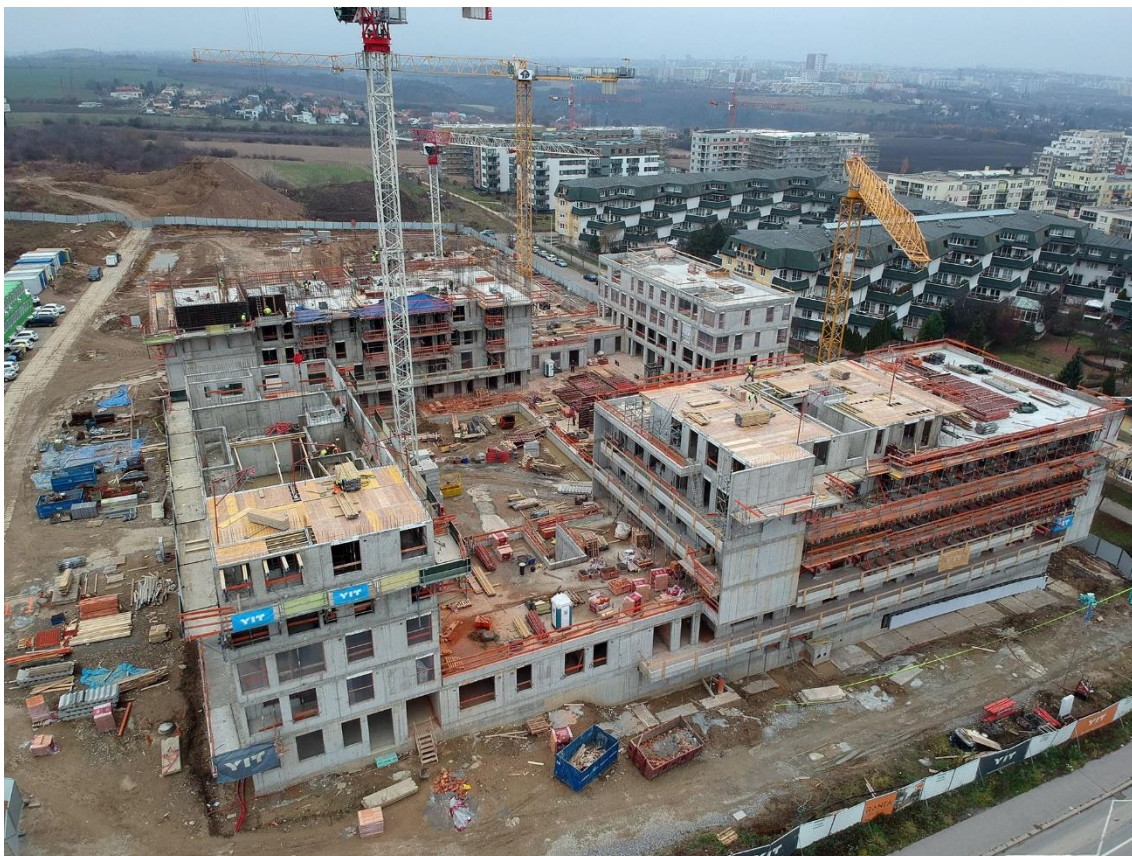
Obr. č. 37 Dokončování hrubé vrchní stavby Bloku 1
