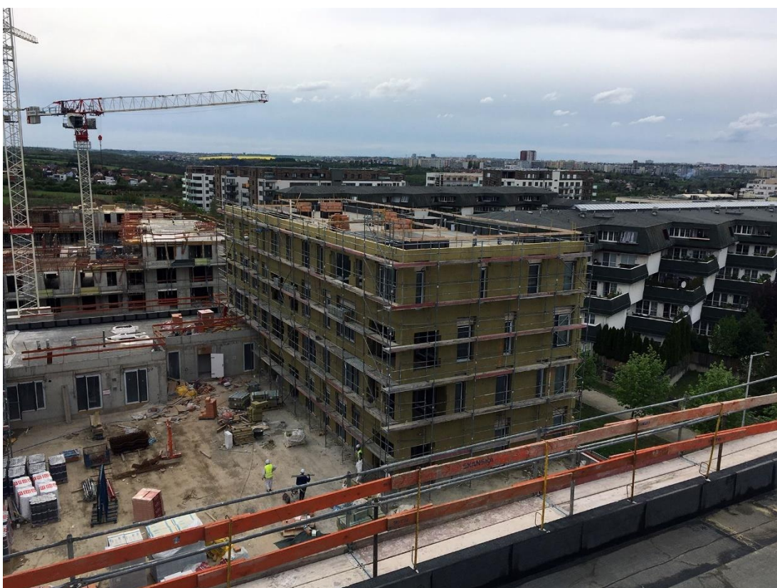
Obr. č. 41 Realizace ploché střechy a fasád Bloku 1
