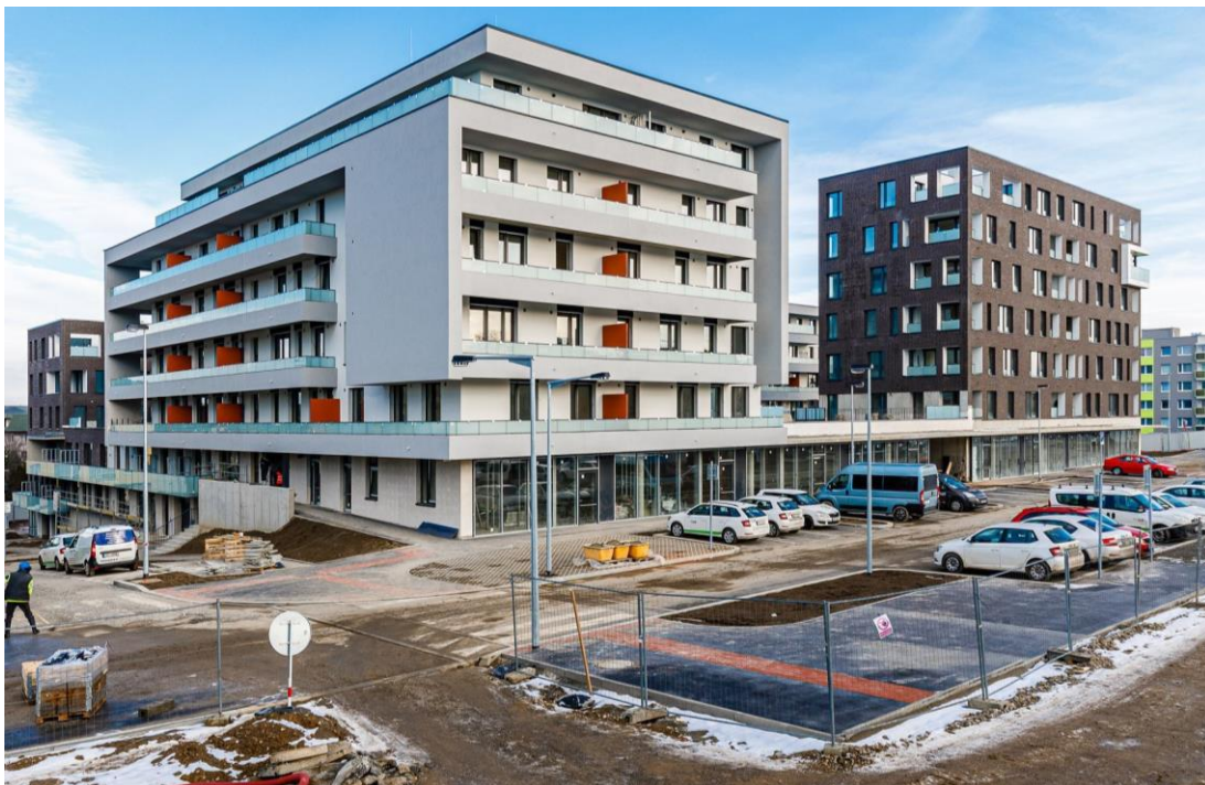
Obr. č. 42 Dokončení Bloku 1 pro kolaudaci. Realizování komunikací a chodníků.
