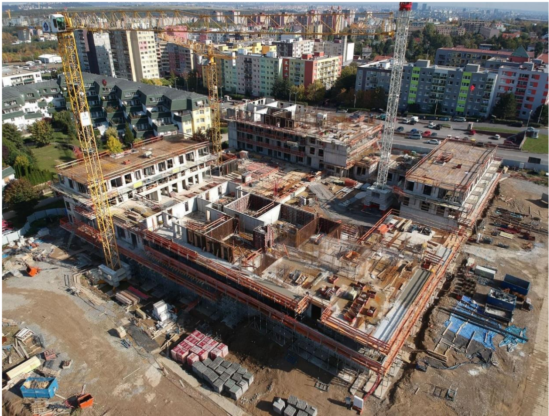
Obr. č. 36 Hrubá vrchní stavba Bloku 1
