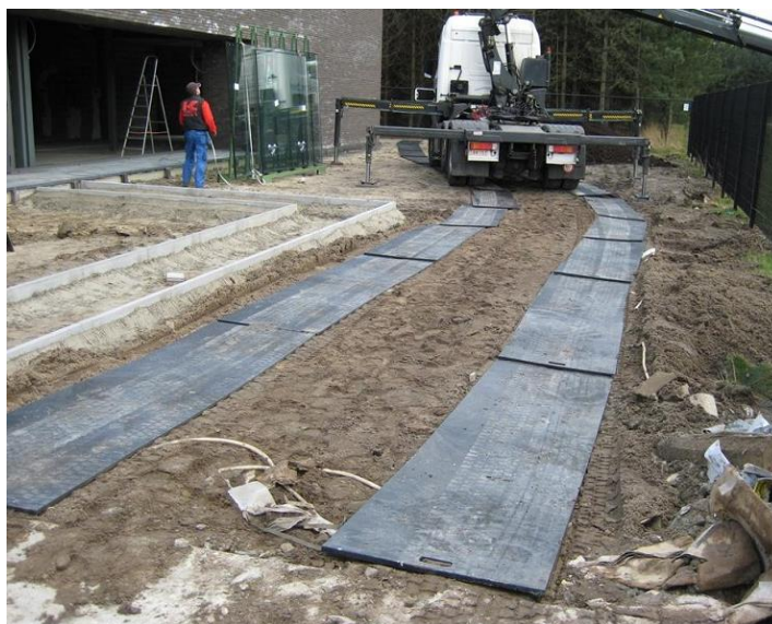
Obr. č. 8 Staveništní komunikace z plastových panelů (11)
