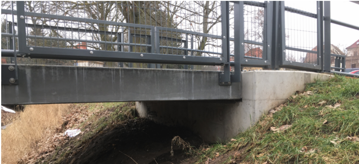
Obrázek 8: Odlišná barevnost UHPC a běžného betonu
