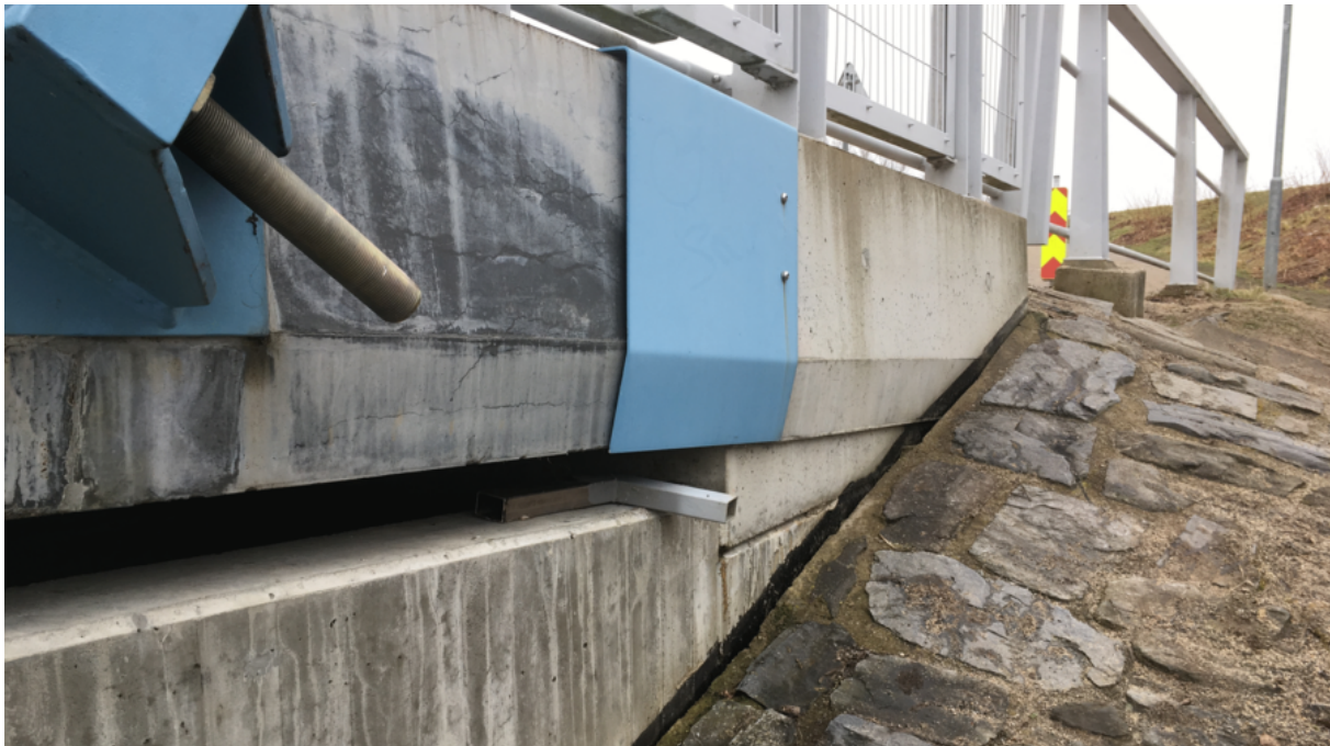
Obrázek 12: Pohled na opěru
