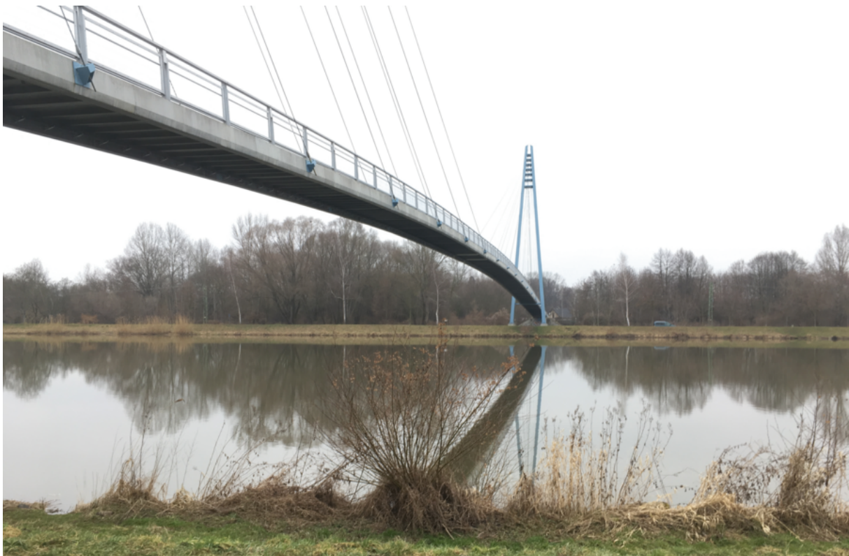
Obrázek 9: Pohled na lávku ve směru toku Labe
