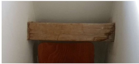
Obr. 49: Foto 1: degradace ve vikýři
