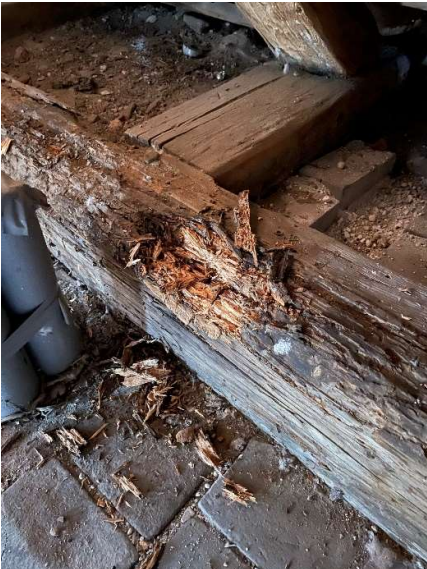
Obr. 46: Foto 17 – dřevokazné houby
