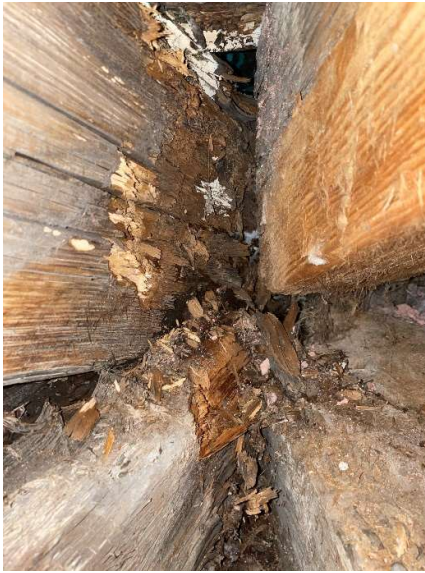
Obr. 48: Foto 20 – Degradace zatékáním
