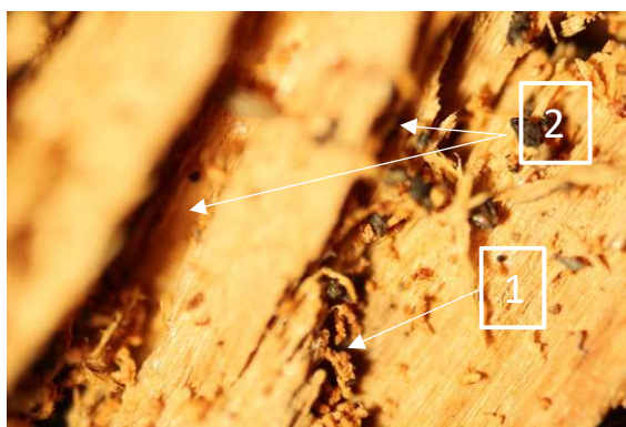
Obr. 54: Stopy po působení červotoče: 1 – zbytky trusu; 2 - chodbičky
