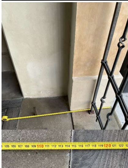
Obr. 7 Detail tloušťky zdi v průjezdu
