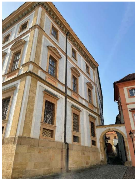
Obr. 12: Boční (severní) fasáda
