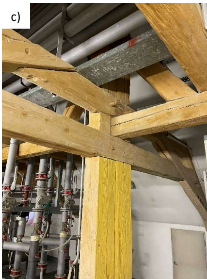
Obr. 17: Barokní krov-a) šikmé sloupky; b) svislé sloupky; c) spoje-plát + kolík; d) rybinový spoj
