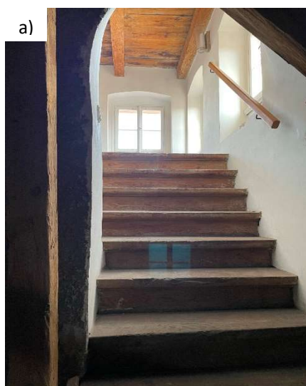
Obr. 9: a) dřevěné schodiště; b) kamenné schodiště
