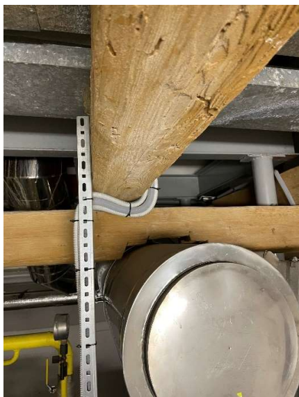
Obr. 38. Foto 11 – dřevokazný hmyz + nevhodný zásah
