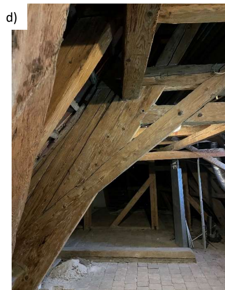
Obr. 17: Barokní krov-a) šikmé sloupky; b) svislé sloupky; c) spoje-plát + kolík; d) rybinový spoj
