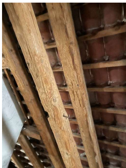
Obr. 43: Foto 16 - dřevokazný hmyz
