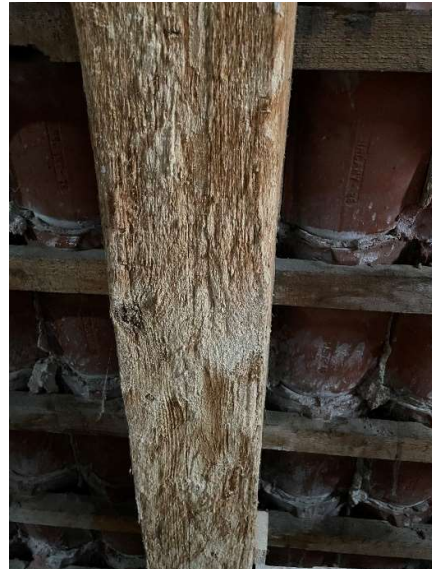
Obr. 47: Foto 15 – rozvláknění
