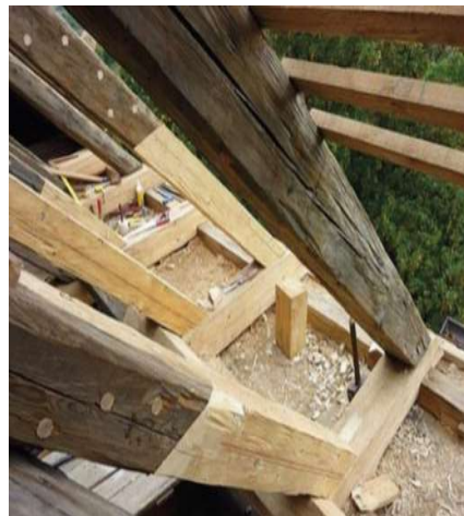
Obr. 120: Protéza krokví napojena rovným plátováním [9]
