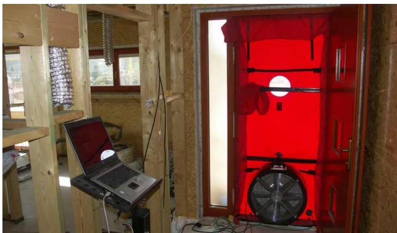
Obrázek 1: Měření neprůvzdušnosti pomocí Blower-Door testu, převzato z [8]
