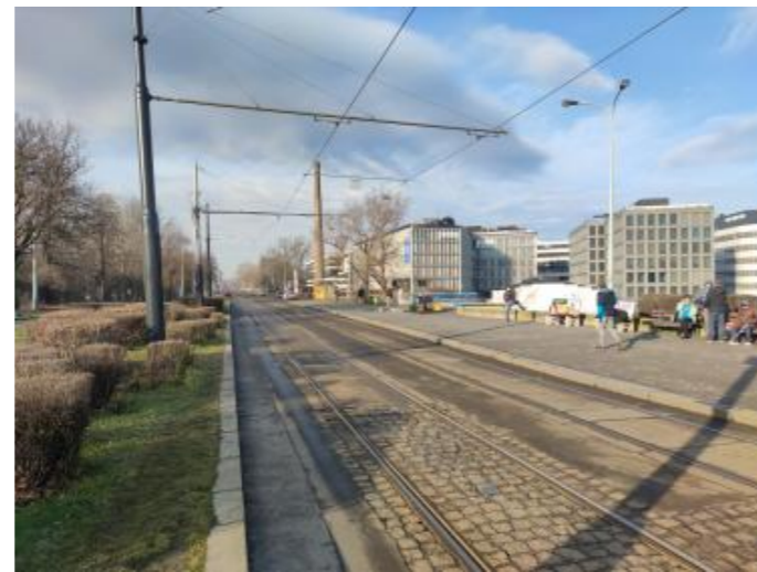
Pohled na osu Libeňského mostu
