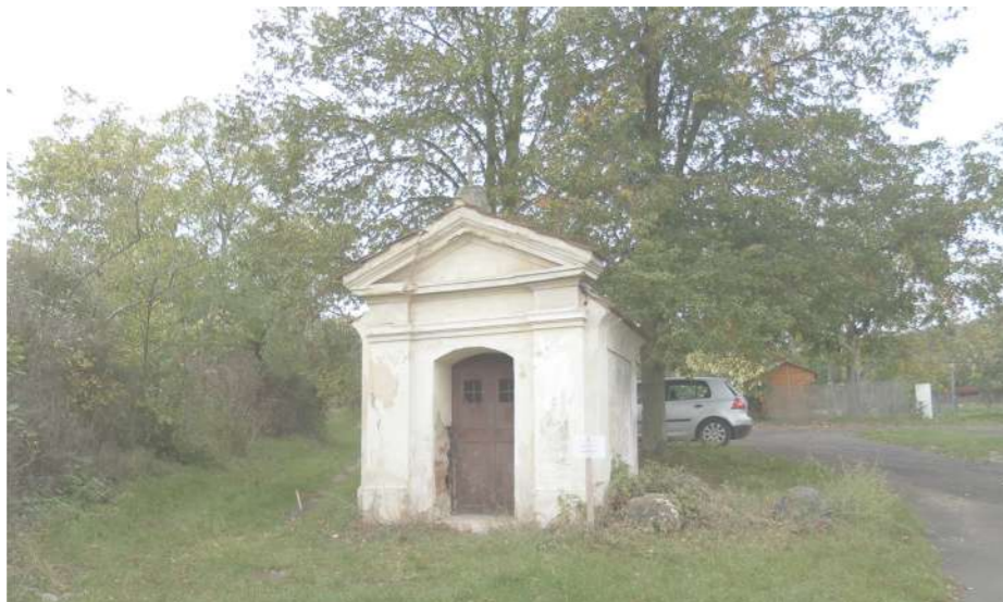
9 - Poutní kaple na rozcestí uvnitř zahrádkářské kolonie
