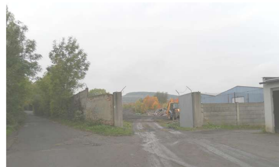
2 - Nový účelový vjezd do areálu (soukromá skláda sutí a stavebního materiálu)
