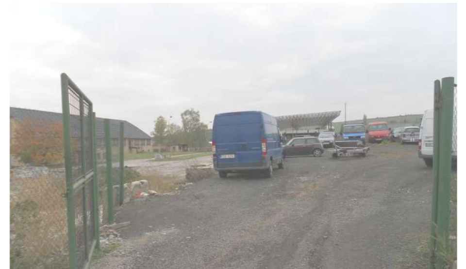
18 - Druhý západní vjezd do areálu z účelové komunikace (výroba a skladování)
