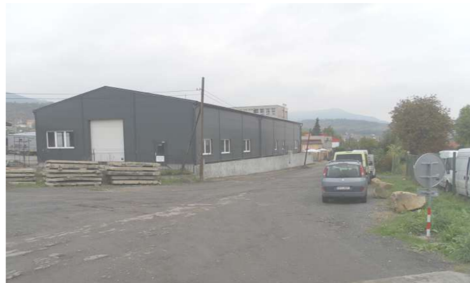
18 - Účelová komunikace podél západní strany areálu (navazuje na pěší stezku)
