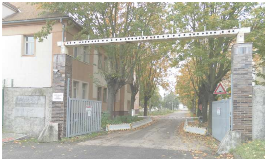
25 - Hlavní vjezd do areálu ze severu (vlevo depozitář národního písemnictví)
