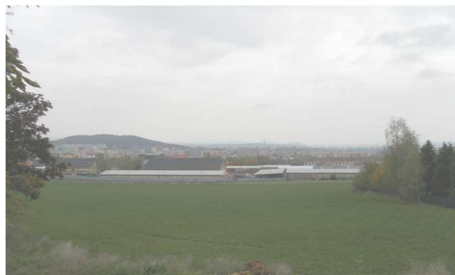
16 - Západní pohled na areál z pěší cesty (na horizontu vlevo vrch Mostka)
