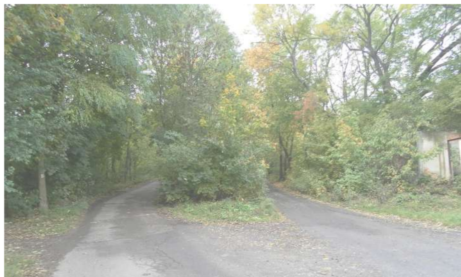
5 - Rozdvojení účelové komunikce (vpravo odbočka do zahrádkářské kolonie)
