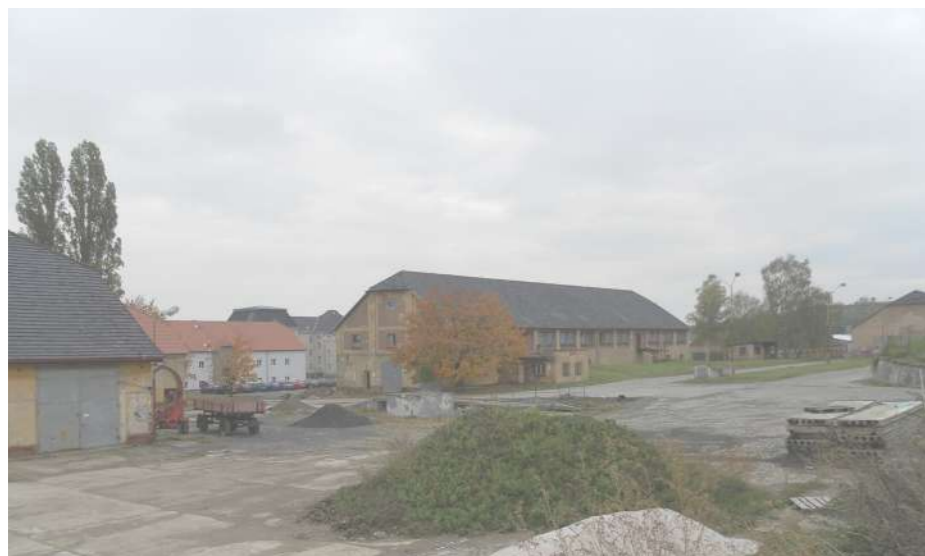
20 - Severovýchodní pohled na areál (uprostřed jedna z historických budov)
