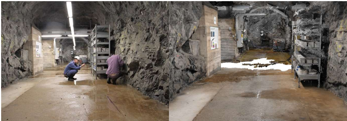
Obrázek 37 - Skutečný snímek pořízený v podzemním výzkumném pracovišti
