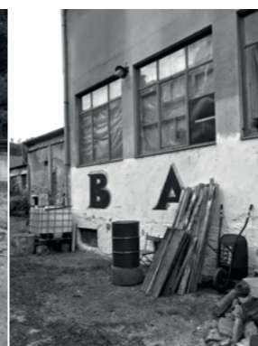
Stávající stav areálu bezútěšný stav
