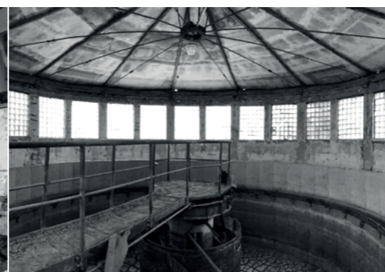
Zastřešená papírenská nádrž Zajímavý prvek hodný zachování
