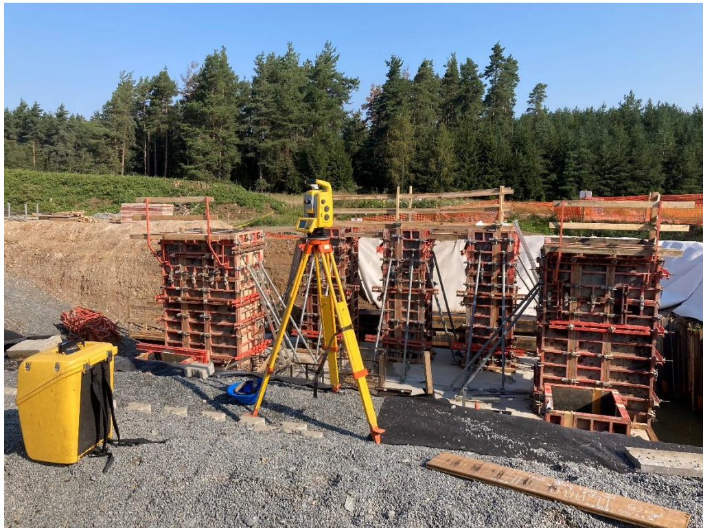
Obr. 27 Betonové pilíře, Zdroj: Autor
