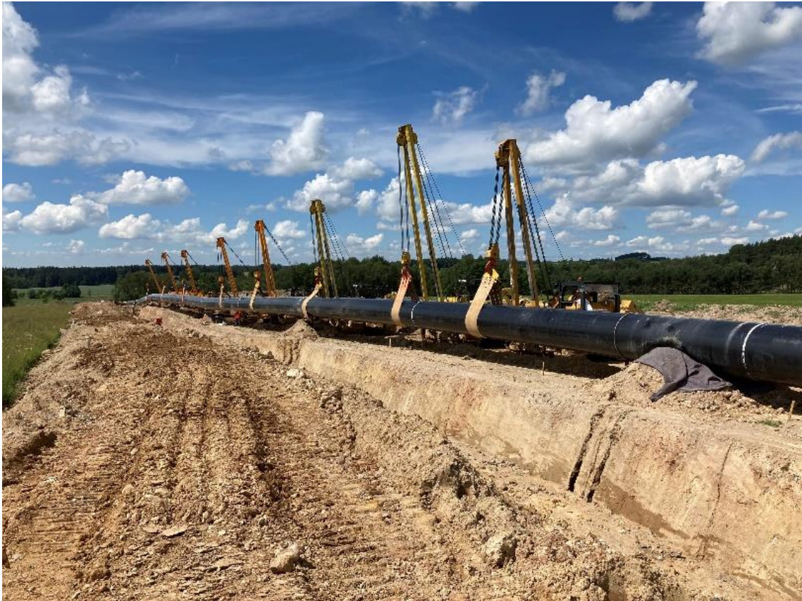
Obr. 3 Pokládka potrubí do výkopu Zdroj: Autor
