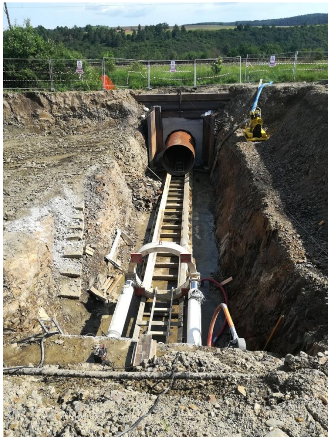
Obr. 21 Protlak pod železnici Zdroj: Autor
