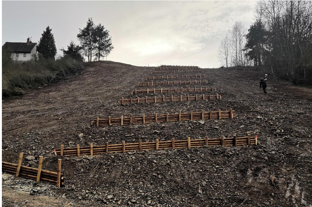
Obr. 31 Palisády, Zdroj: Autor
