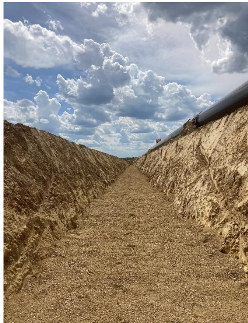
Obr. 13 Výkop, Zdroj: Autor
