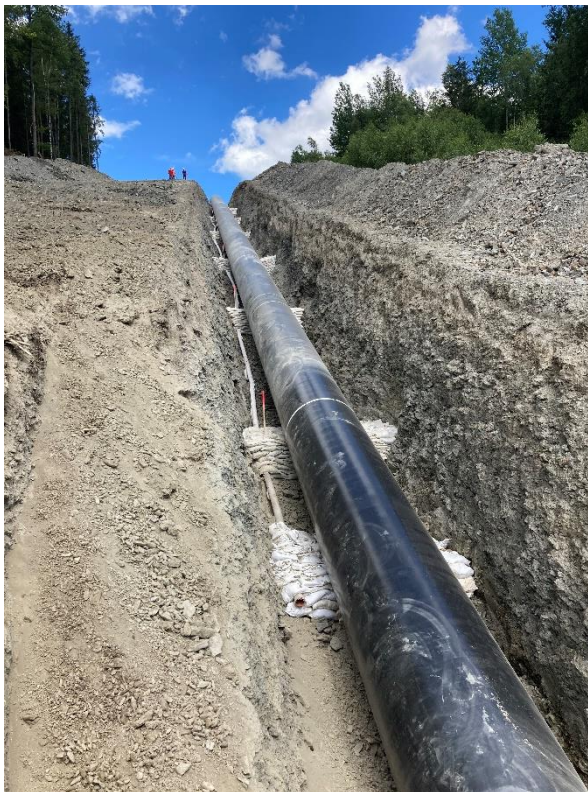
Obr. 17 Potrubí ve strmém kopci Zdroj: Autor
