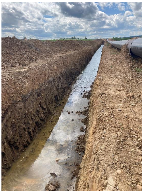
Obr. 14 Výkop plný dešťové vody Zdroj: Autor
