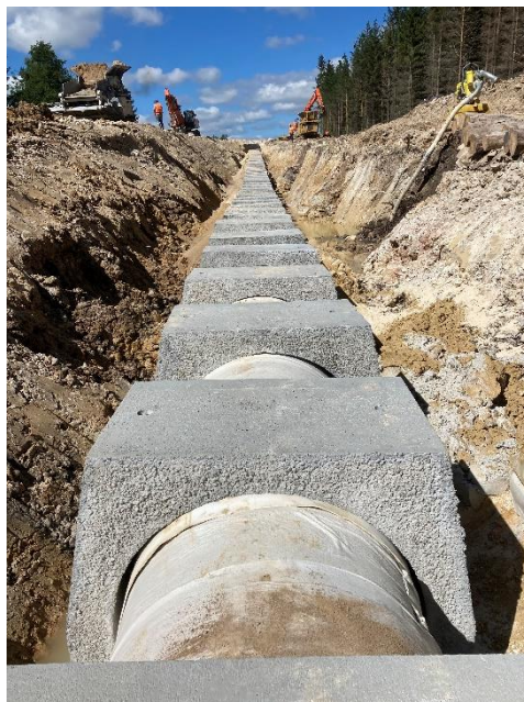
Obr. 18 Betonová sedla Zdroj: Autor
