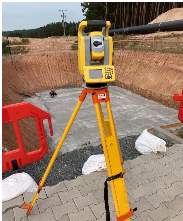
Obr. 26 Vytyčování základové desky na podkladní beton Zdroj: Autor
