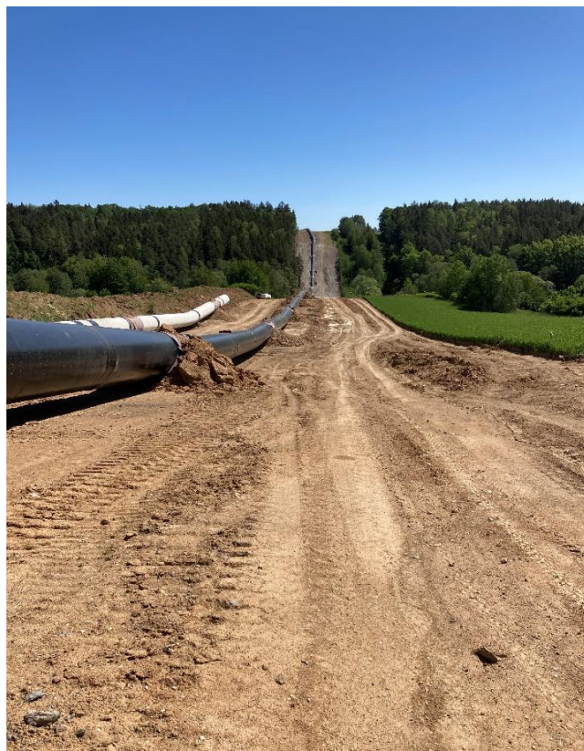
Obr. 12 Pracovní pruh před vytyčením osy plynovodu Zdroj: Autor
