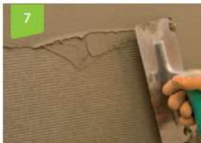
Obrázek 9: Montáž KZS - Základní vrstva
