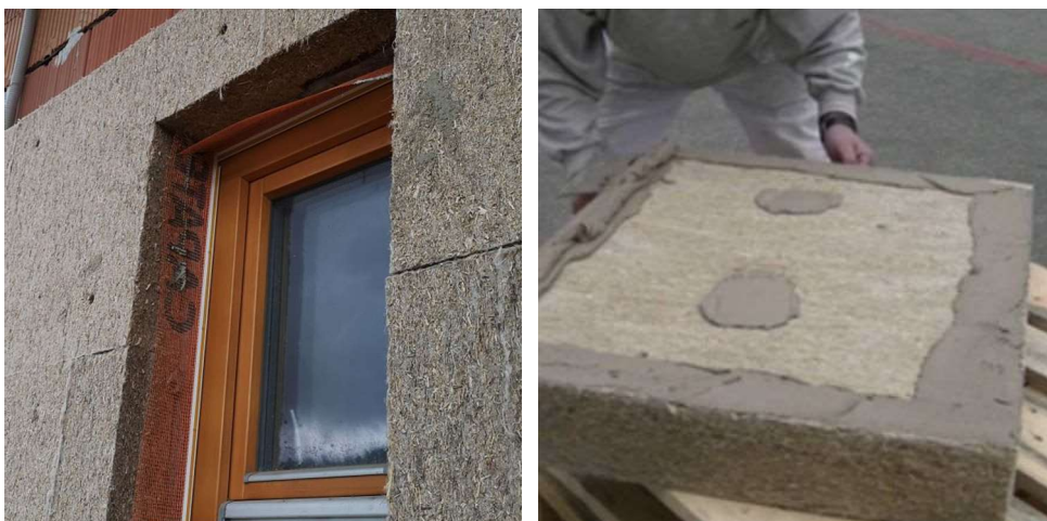
Obrázek 21: Ukázka realizace zateplení z technického konopí
