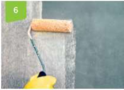
Obrázek 8: Montáž KZS - Penetrace podkladu
