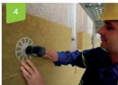
Obrázek 6: Montáž KZS - Kotvení hmoždinkami
