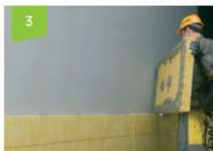
Obrázek 5: Montáž KZS - Lepení desek
