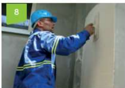
Obrázek 10: Montáž KZS - Provádění povrchových úprav
