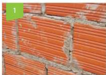
Obrázek 3: Montáž KZS - Příprava podkladu
