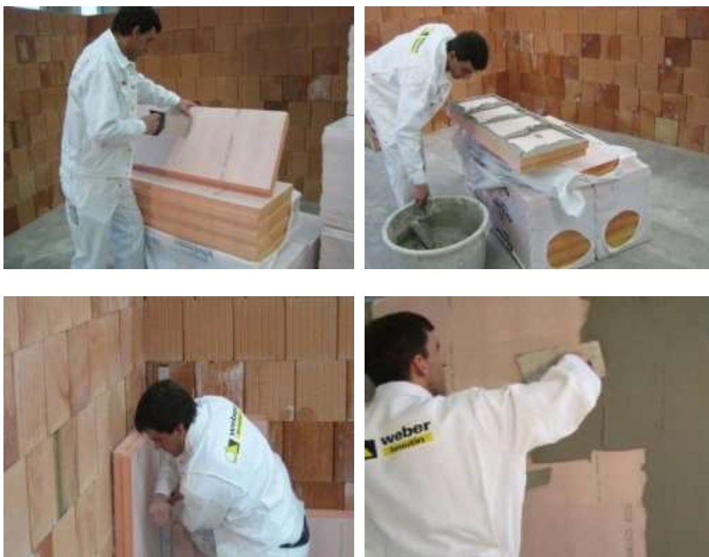
Obrázek 17: Montáž tepelněizolačních desek z fenolické pěny
