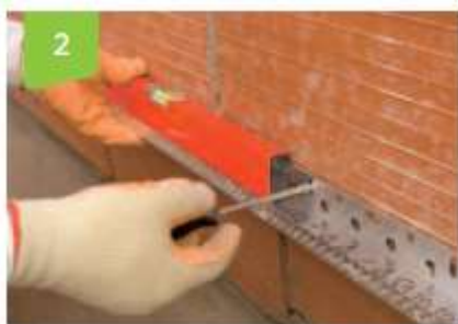
Obrázek 4: Montáž KZS - Založení zateplení
