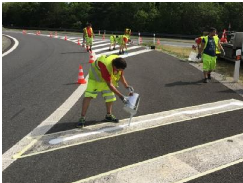
Obrázek č. 21-Realizace vodorovného dopravního značení stěrkovým plastem. Zdroj [15]
