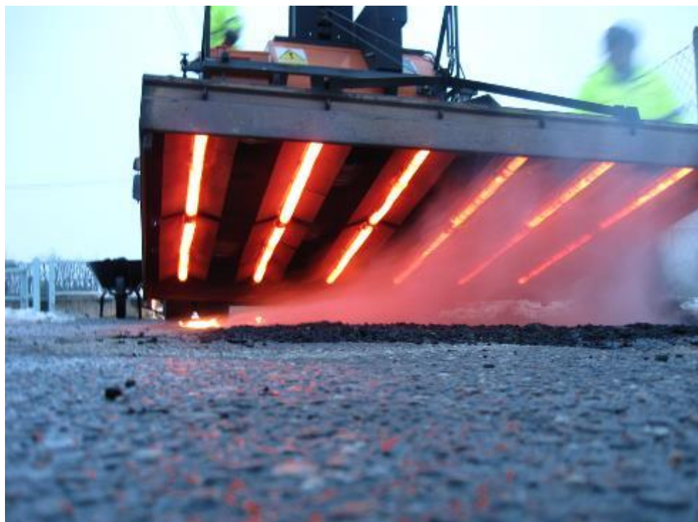
Obrázek č. 20 – Nahřátí postiženého místa infrazářiči. Zdroj [13]
