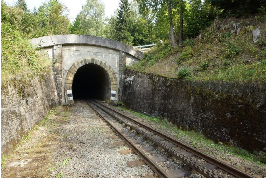
Obr. 7 – Vjezdový portál Polubenského tunelu
