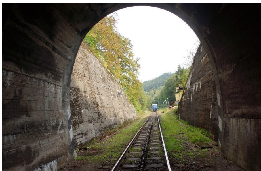
Obr. 6 – Výjezdový portál Dolnopolubenského tunelu
