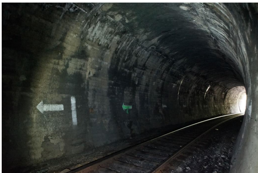
Obr. 32 – Desenský tunel, stříkaný beton v klenbě
