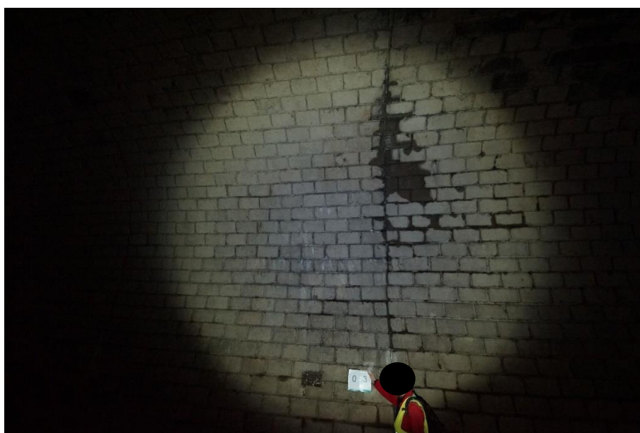
Obr. 56 – Polubenský tunel, průsak mezi pasy
