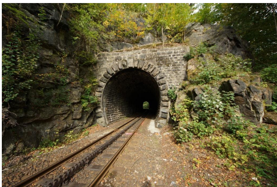
Obr. 1 – Vjezdový portál Žďárského tunelu
