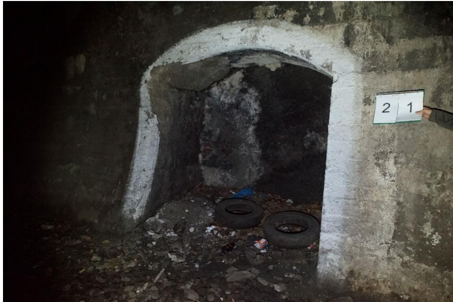
Obr. 29 – Desenský tunel, záchranný výklenek
