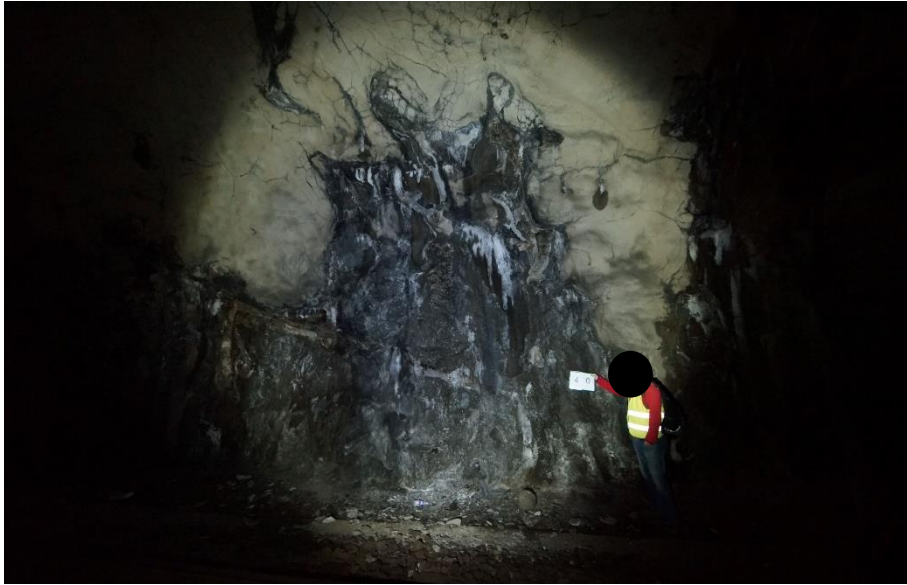
Obr. 60 – Polubenský tunel, stříkaný beton bez výztuže
