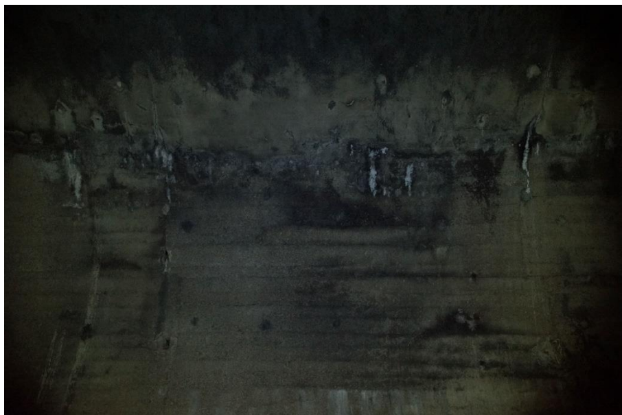
Obr. 33 – Desenský tunel, betonové ostění v pasu 9
