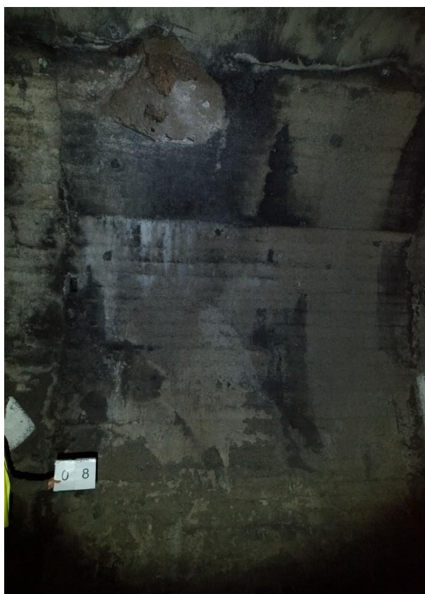
Obr. 36 – Desenský tunel, díra v ostění v pasu 8
