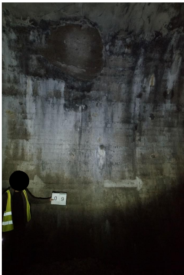
Obr. 35 – Desenský tunel, díra v ostění v pasu 9
