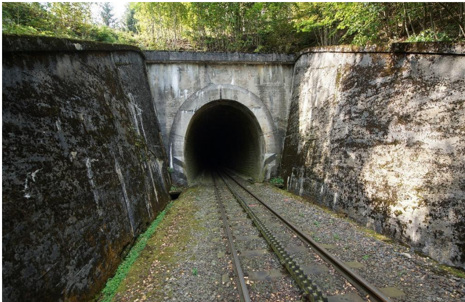
Obr. 8 – Výjezdový portál Polubenského tunelu
