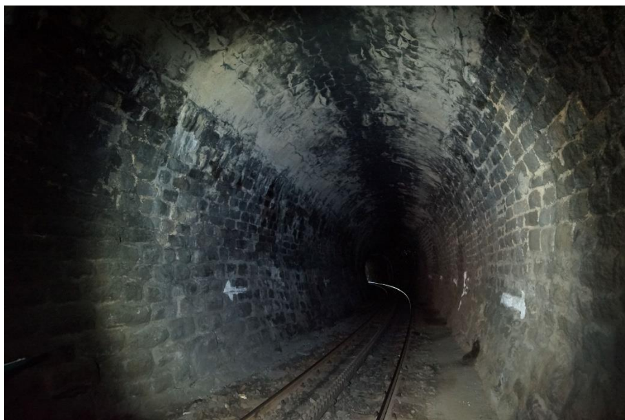
Obr. 45 – Dolnopolubenský tunel, stříkaný beton v klenbě
