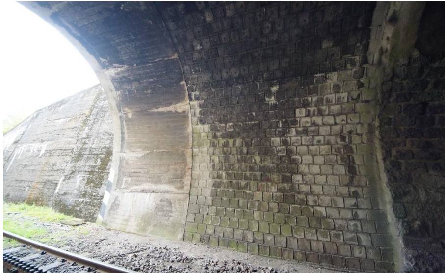
Obr. 44 – Dolnopolubenský tunel, betonové tvárnice
