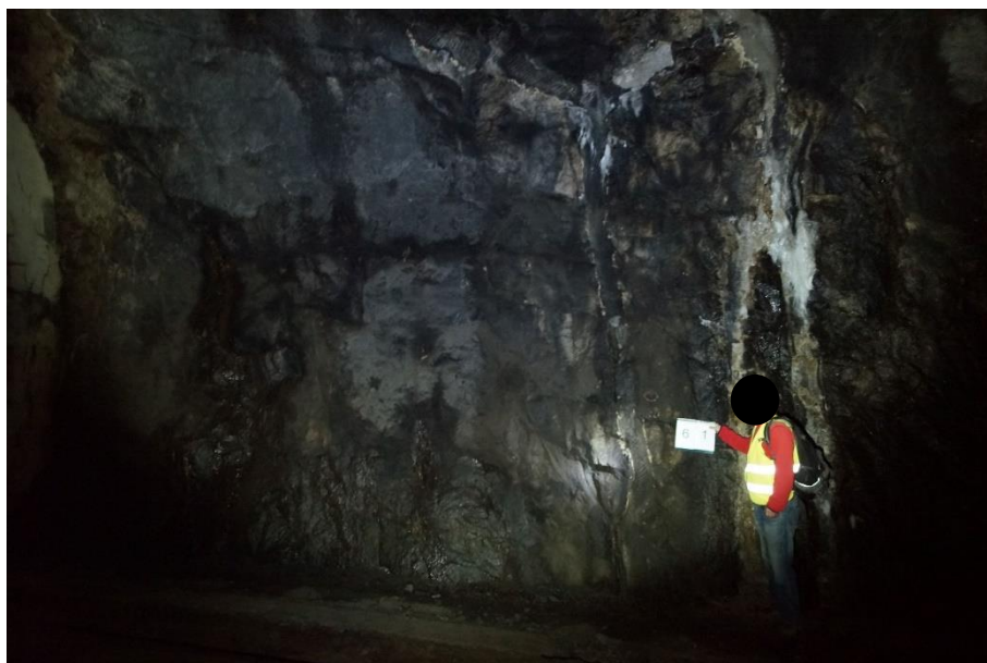
Obr. 63 – Polubenský tunel, skalní líc se svodnicí
