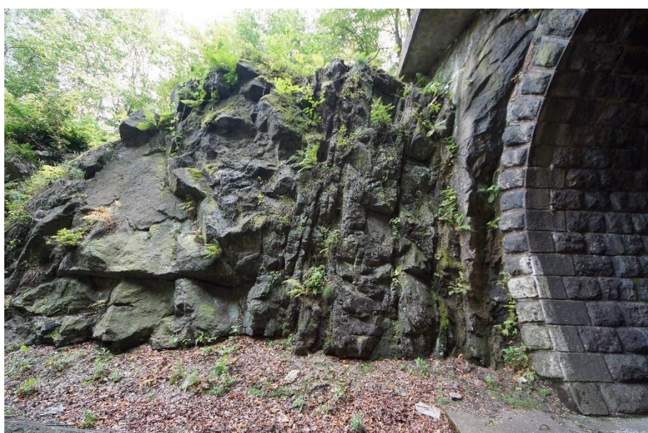
Obr. 2 – Výjezdový portál Žďárského tunelu
