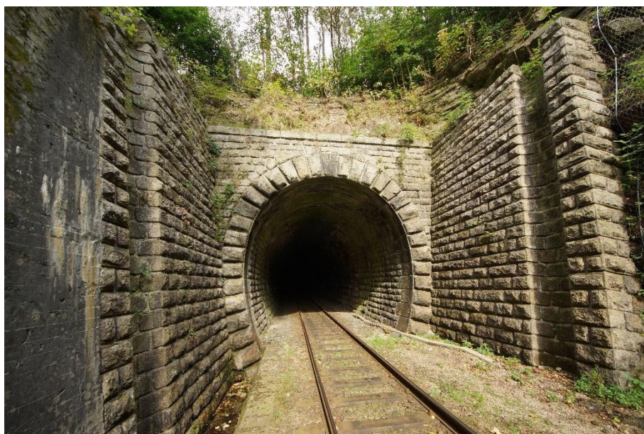
Obr. 3 – Vjezdový portál Desenského tunelu
