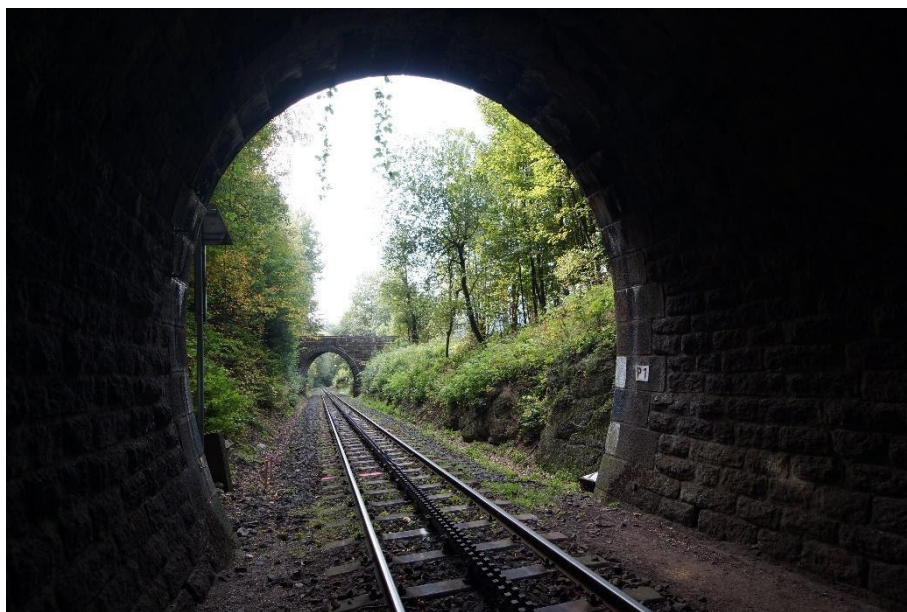
Obr. 5 – Vjezdový portál Dolnopolubenského tunelu
