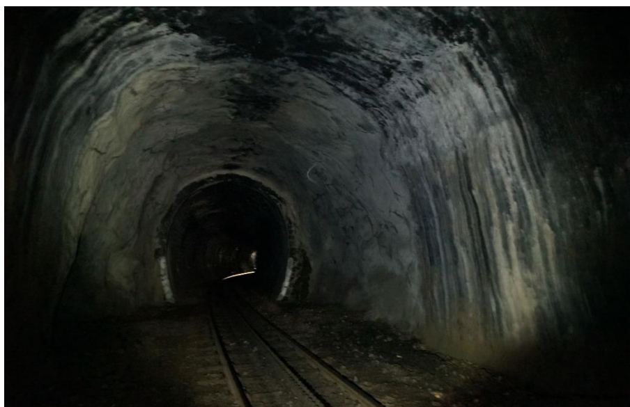
Obr. 43 – Dolnopolubenský tunel, stříkaný beton se sklolaminátovou vrstvou
