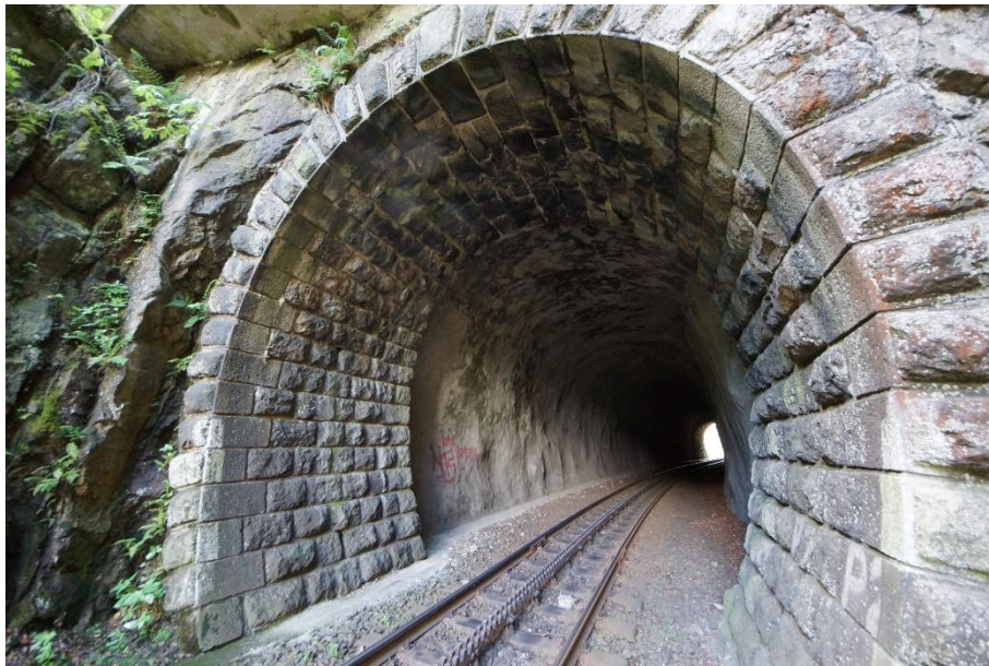
Obr. 17 – Pas P2 Žďárského tunelu
