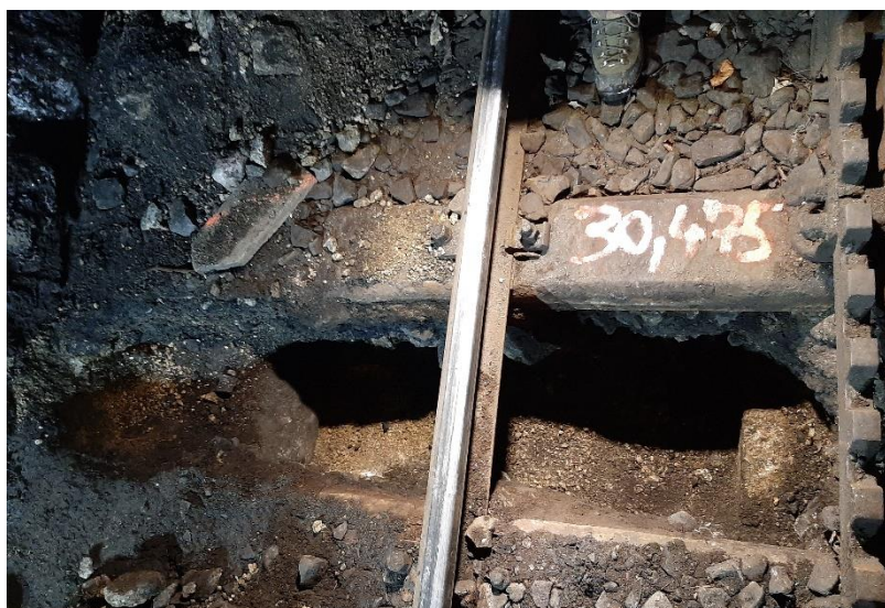
Obr. 48 – Dolnopolubenský tunel, kopaná sonda
