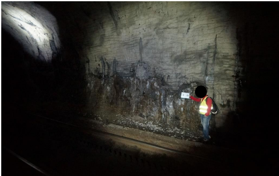
Obr. 61 – Polubenský tunel, stříkaný beton s výztuží
