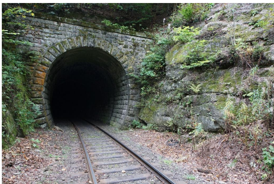
Obr. 4 – Výjezdový portál Desenského tunelu
