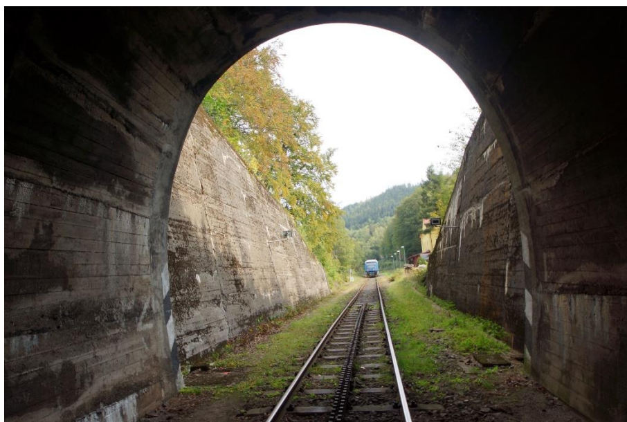
Obr. 46 – Dolnopolubenský tunel, pohled výjezdovým portálem
