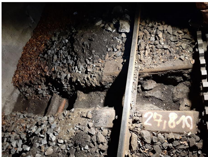
Obr. 22 – Žďárský tunel, kopaná sonda
