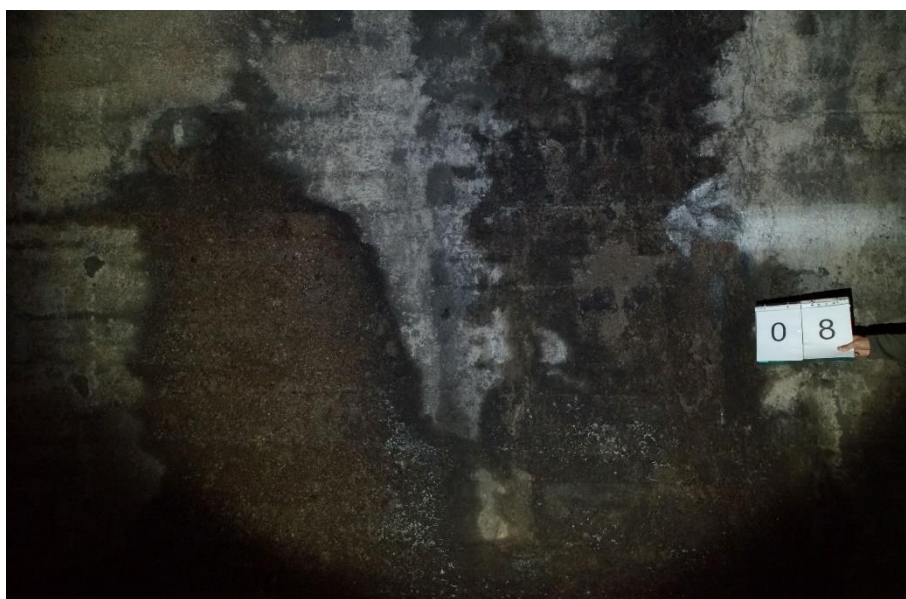
Obr. 34 – Desenský tunel, průsaky ostěním v pasu 8
