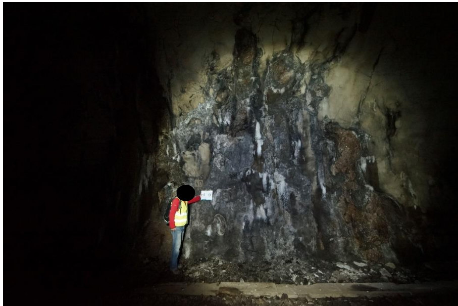
Obr. 59 – Polubenský tunel, stříkaný beton bez výztuže
