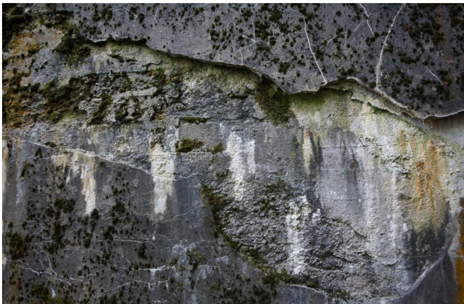
Obr. 66 – Polubenský tunel, zvětralá zárubní zeď
