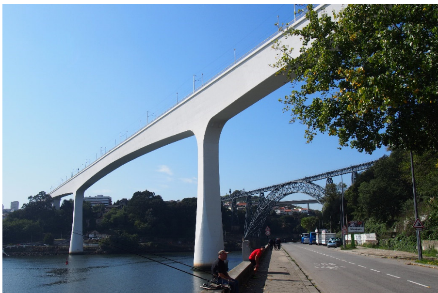
Obr. 1: Železniční most Ponte de São João, Porto, Portugalsko, rozpětí hlavního pole 250 m, v pozadí je historický Ponte de D. Maria Pia od Gustava Eiffela z roku 1877
