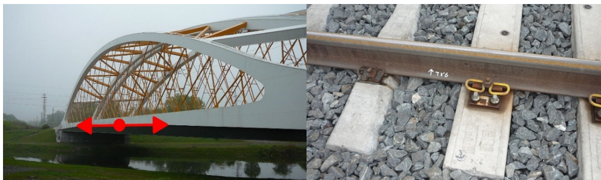
Obr. 28: Vlevo pohled na most zleva, vpravo dvě různé konfigurace koleje na mostě – běžná konfigurace (svěrky bez PKO) a konfigurace snižující účinky interakce (žluté svěrky)
