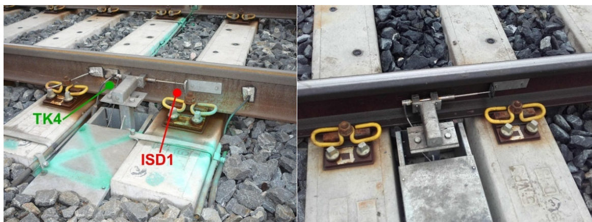
Obr. 33: Vlevo indukční snímač ISD1 a tenzometr TK4 nad Vídeňskou opěrou, vpravo indukční snímač ISD2 nad Břeclavskou opěrou
