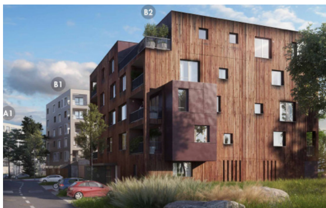
Obrázek 8 Byt Byty u Šárky
