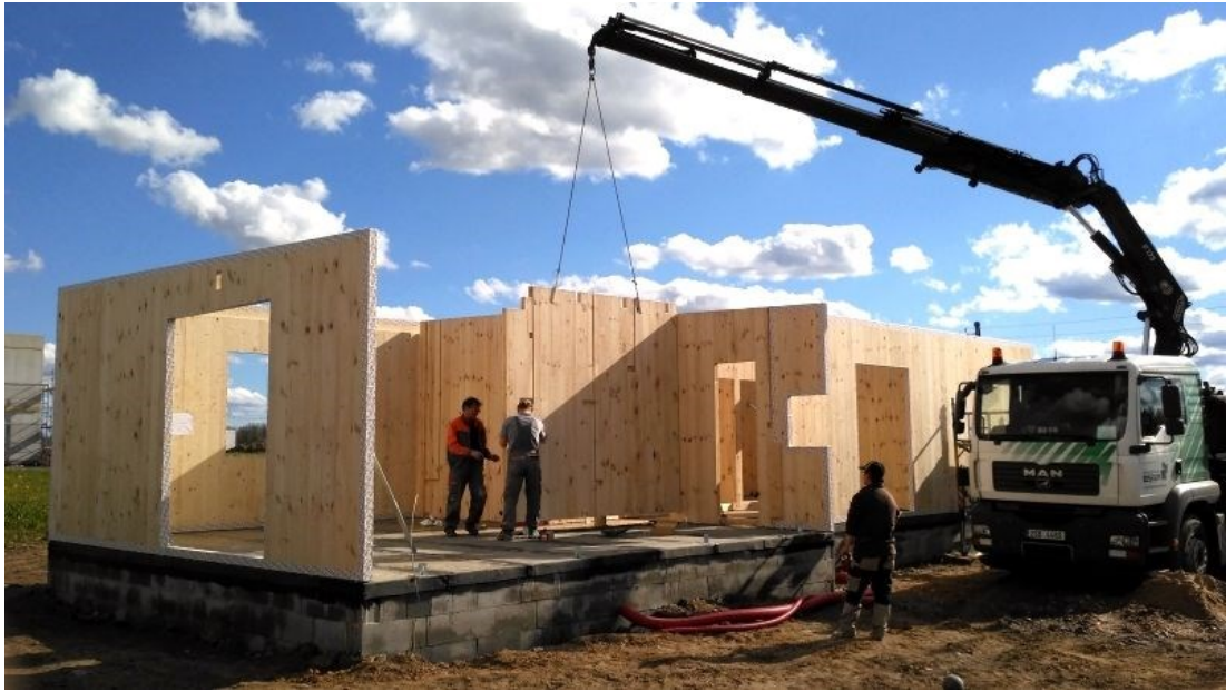
Obr. č. 9 - Dřevostavba z CLT panelů
