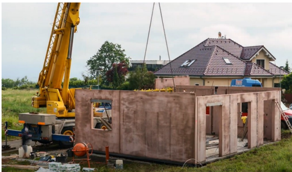
Obr. č. 16 - Výstavba RD z prefabrikovaných betonových dílců
