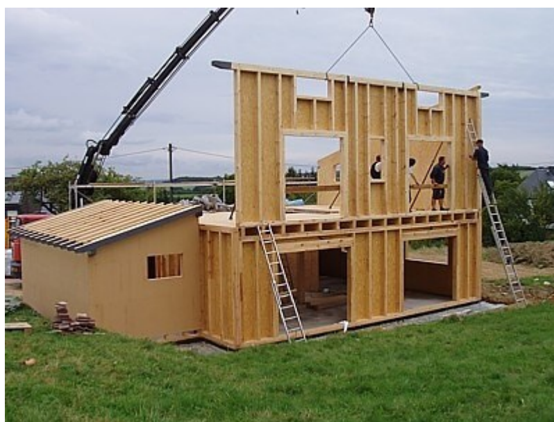
Obr. č. 8 - Výstavba dřevostavby z rámového panelového systému
