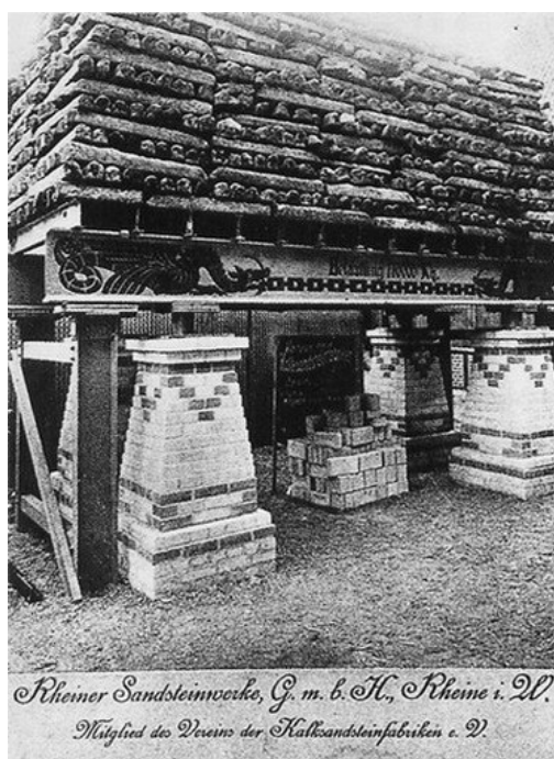
Obr. č. 14 - Zkouška pevnosti v tlaku
