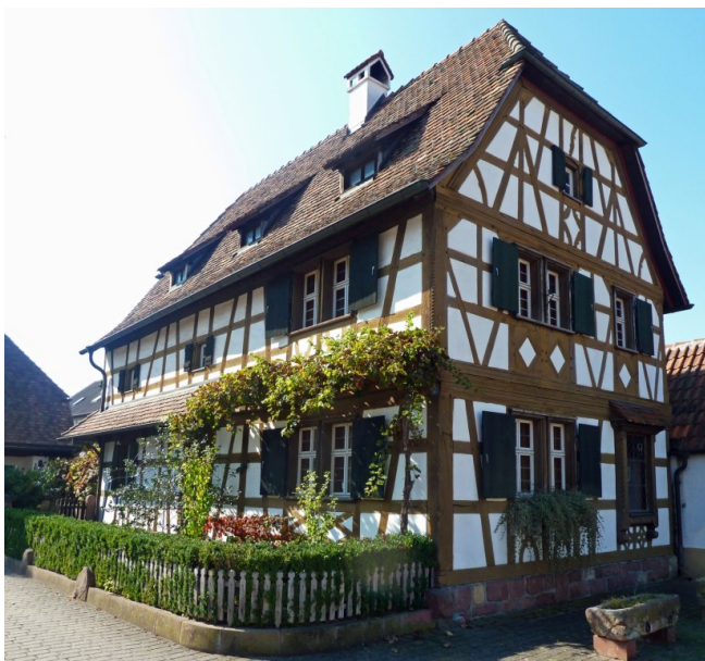
Obr. č. 6 – Hrázděná stavba s viditelnou nosnou konstrukcí
