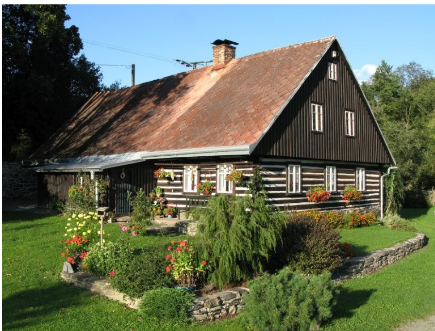
Obr. č. 5 – Typická roubenka v ČR
