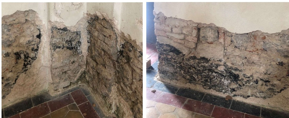
Obr. 40,41 – zbytky nátěru po odkrytí zdiva
