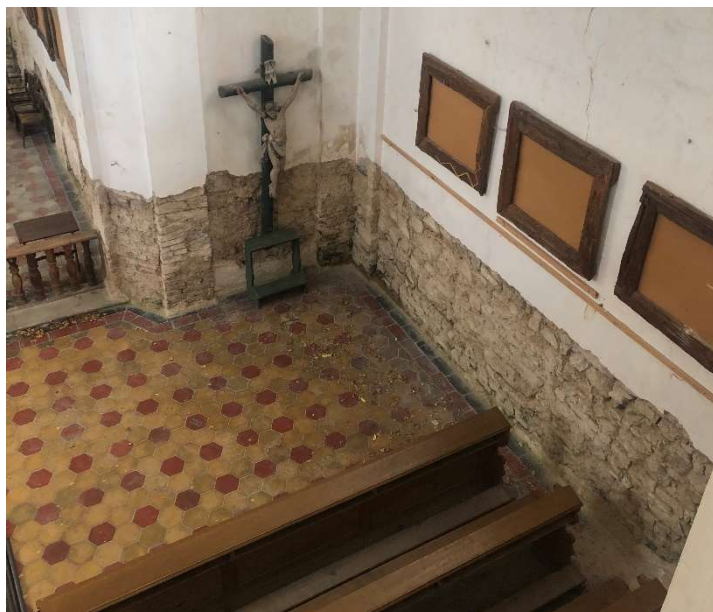
Obr. 32 – oklepané soklové části
