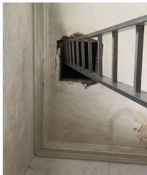
Obr. 18 – štuková lišta a výlez do konstrukce krovu
