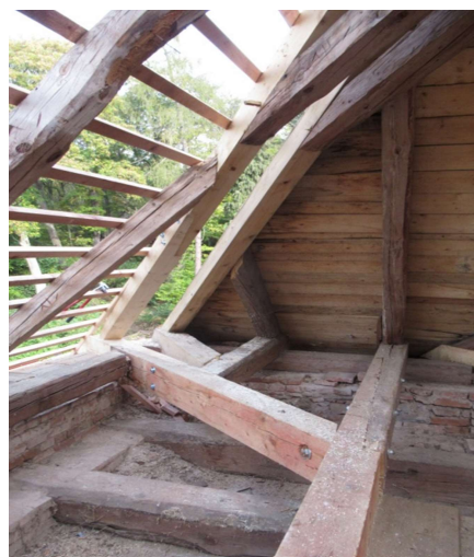
Obr. 13 - detail krovu po provedení oprav s novým laťováním pro pokládání krytiny (autor fotografie: Biskupství plzeňské)
