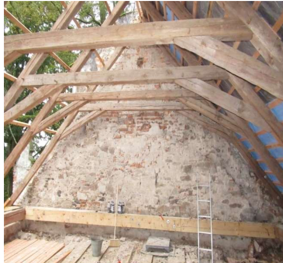
Obr. 23 – odkrytá konstrukce krovu v době oprav (autor fotografie: Biskupství plzeňské)
