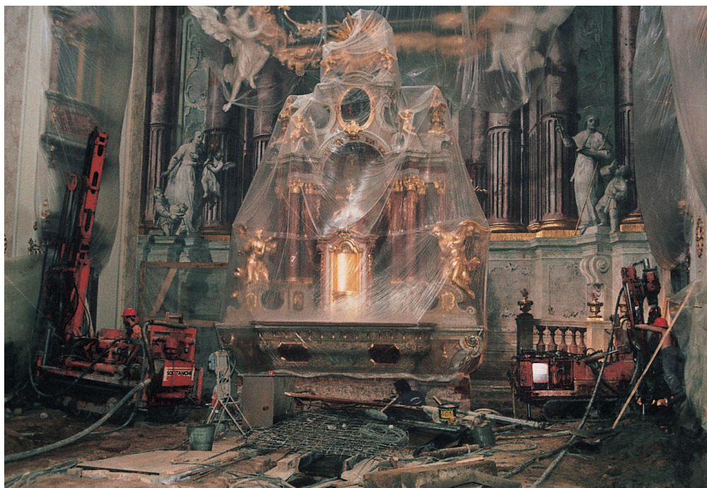
Ukázky podchycování základů u historických objektů (Kostel sv. Františka Xaverského, Uherské Hradiště)
