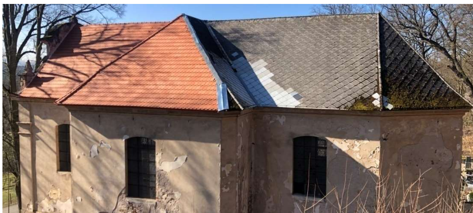
Obr. 24 – pohled na střešní konstrukci po první části oprav
