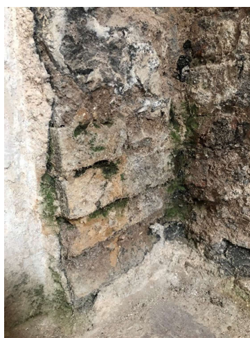
Obr. 45 – detail napadení prvků mechy/řasami
