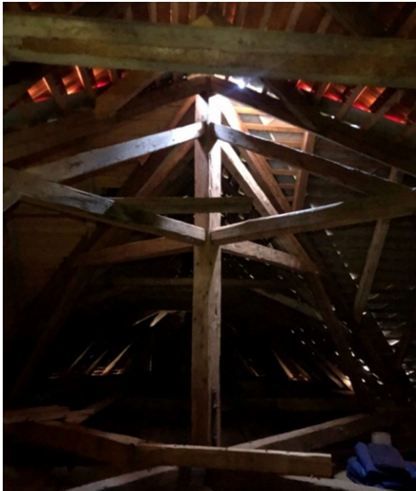
Obr. 22 – mohutný sloupek v místě křížení krovů
