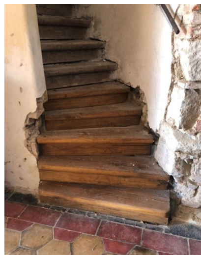
Obr. 20 – schodiště vedoucí na kruchtu
