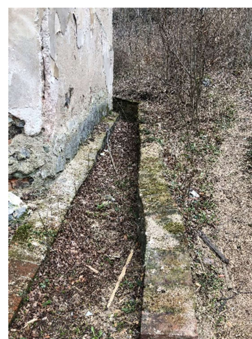
Obr. 46 – historický odvodňovací žlab
