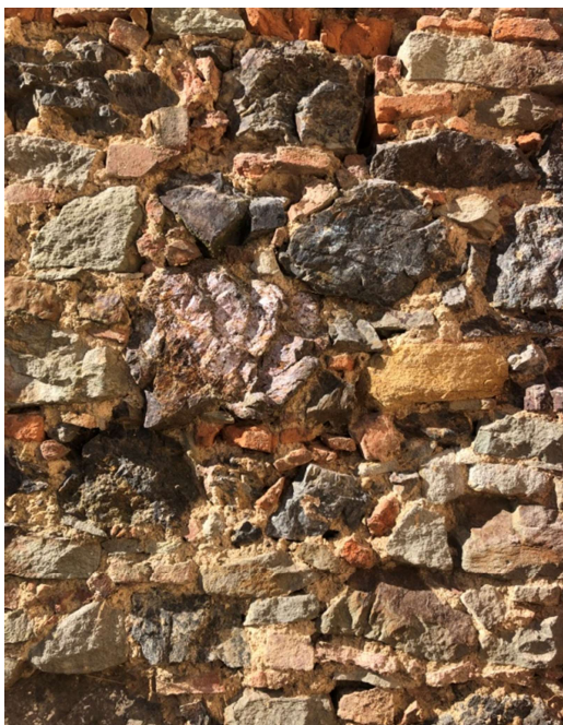
Obr. 16 – detail smíšeného zdiva z exteriéru
