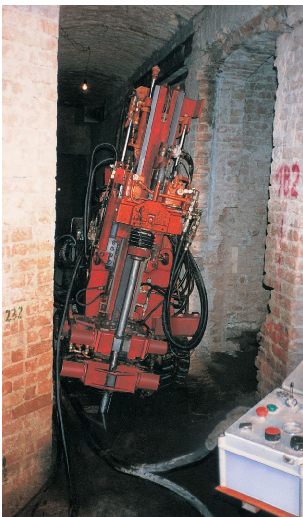
Provádění trykové injektáže ve sklepních prostorách rekonstruovaného objektu
