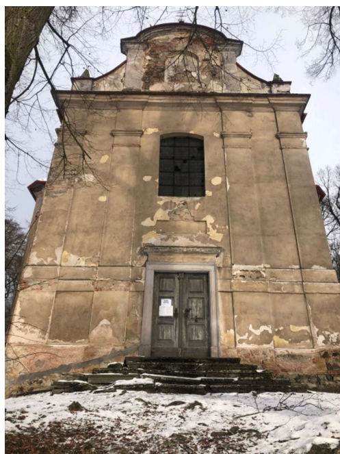
Obr. 6 – pohled jižní - průčelí
