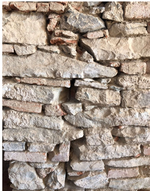
Obr. 17 – detail smíšeného zdiva z interiéru
