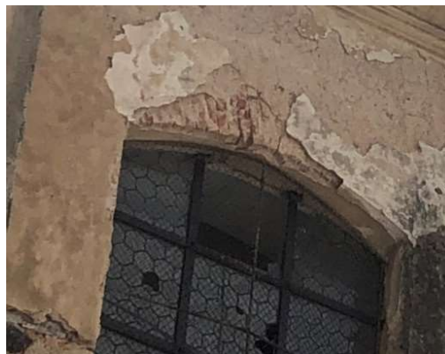
Obr. 25– detail obnaženého cihelného zdiva klenutého nadpraží okenního otvoru
