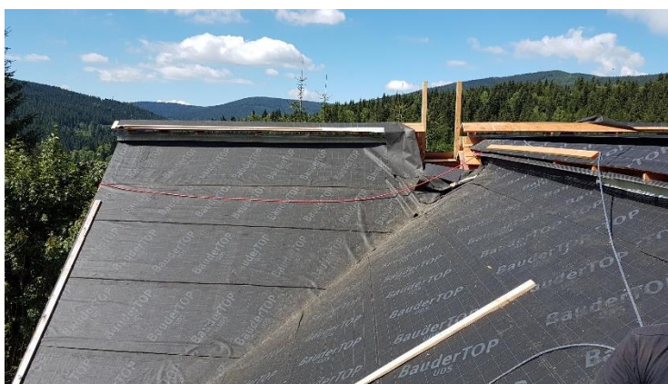
Obrázek 35 - Položená separační vrstva, závětrování latěmi [30]
