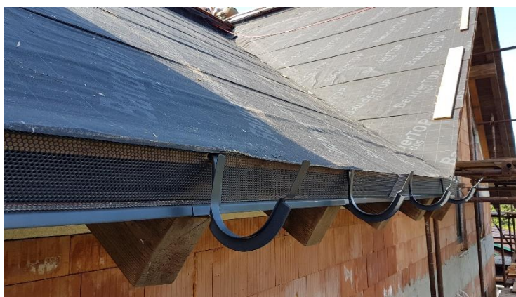
Obrázek 34 - Položená separační vrstva u okapové hrany [30]
