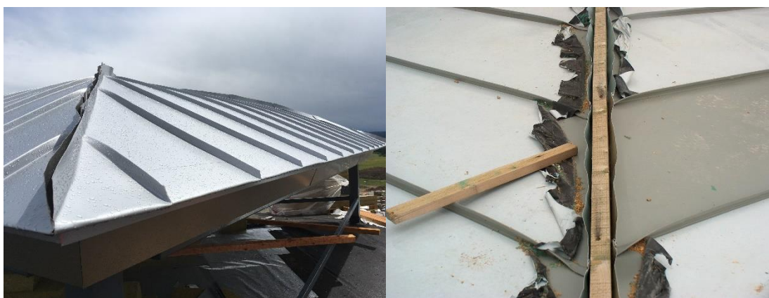
Obrázek 64 - Nároží před uzavřením spoje, vlevo – dvojitá stojatá drážka, vpravo – spoj na lati [30]
