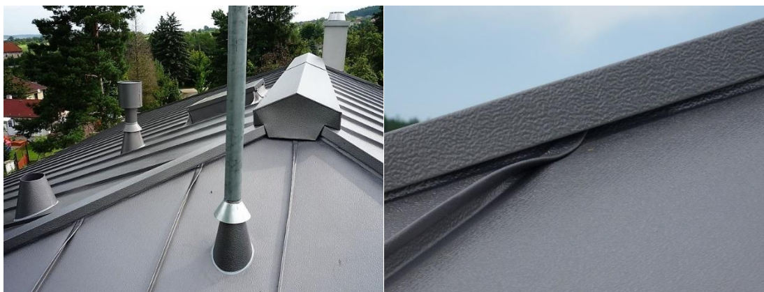
Obrázek 65 - Provedení spoje s položenou drážkou [30]
