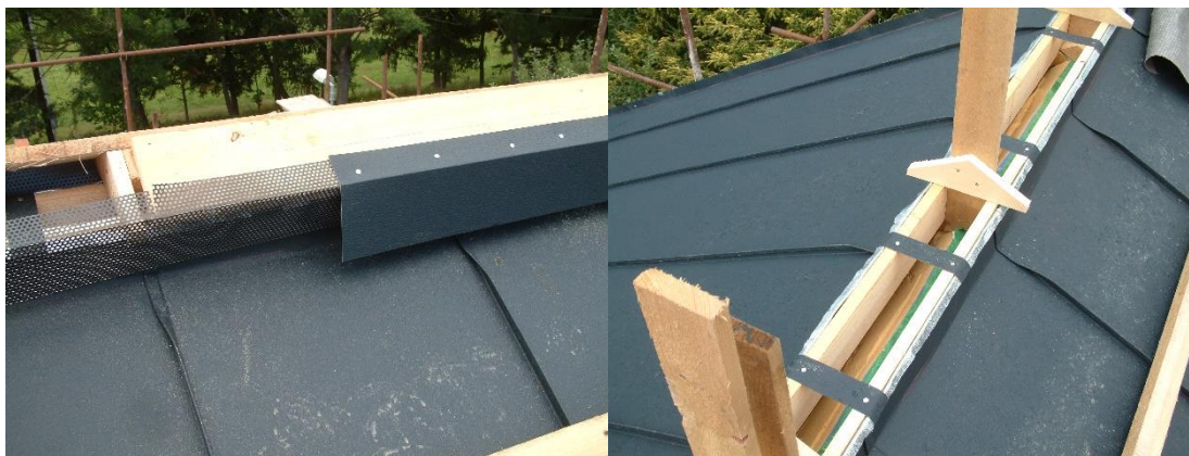
Obrázek 68 - Konstrukce provětrávaného hřebene [30]
