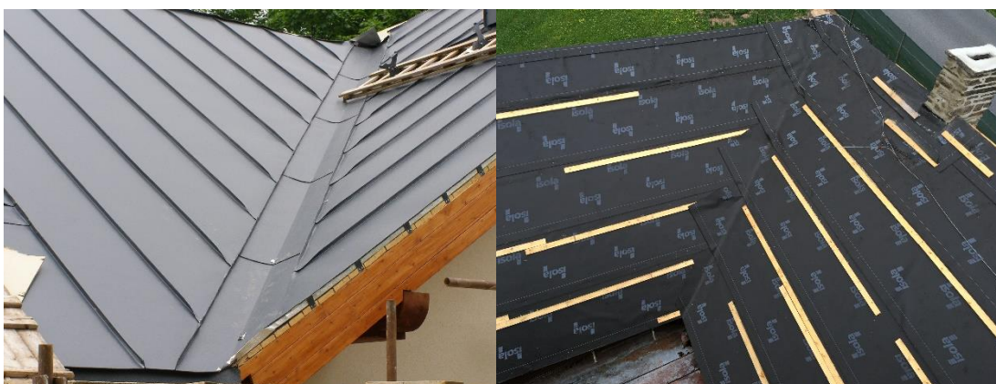
Obrázek 73 - Bezpečnostní úžlabí [30]
