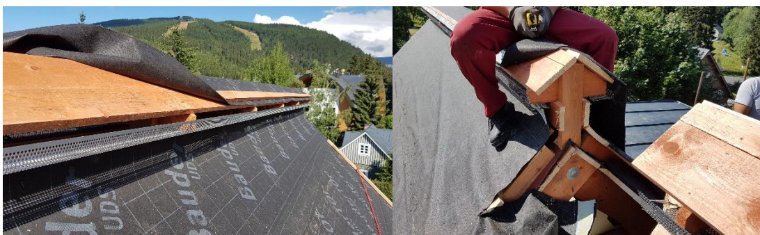
Obrázek 8 - Konstrukce provětrávaného hřebene [30]
