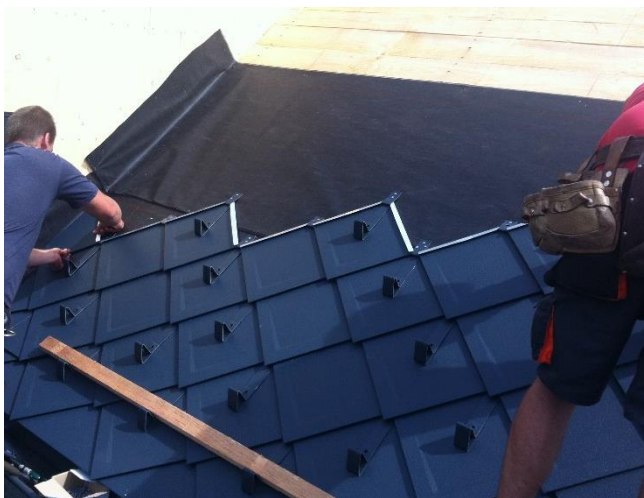
Obrázek 12 - Montáž falcovaných šablon [30]
