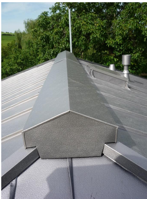
Obrázek 67 - Hotový klempířský provětrávaný hřeben [30]
