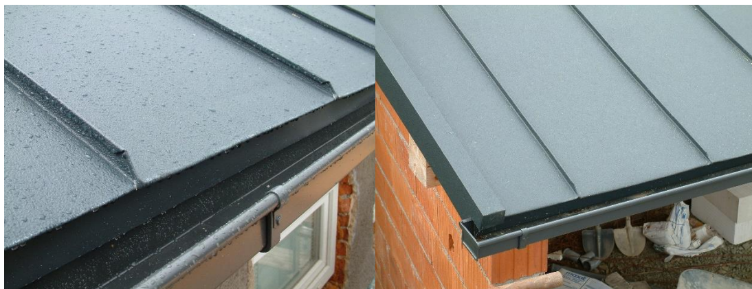
Obrázek 30 -Zakončení okapové hrany, podokapní hranatý žlab [30]
