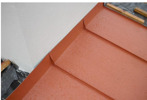
Obrázek 52 - Plech vytažený svisle podél zdi [30]
