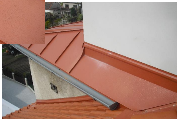
Obrázek 53 - Hotové napojení s krycí lištou [30]
