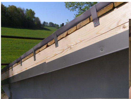
Obrázek 61 - Konstrukce před připevněním závětrné lišty [30]
