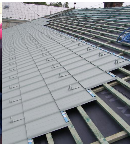
Obrázek 13 - Montáž falcované tašky na laťování [30]
