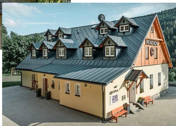
Obrázek 23 - PREFA střešní šablona, na nižších sklonech falcovaná krytina z hliníkového plechu PREFALZ [9]
