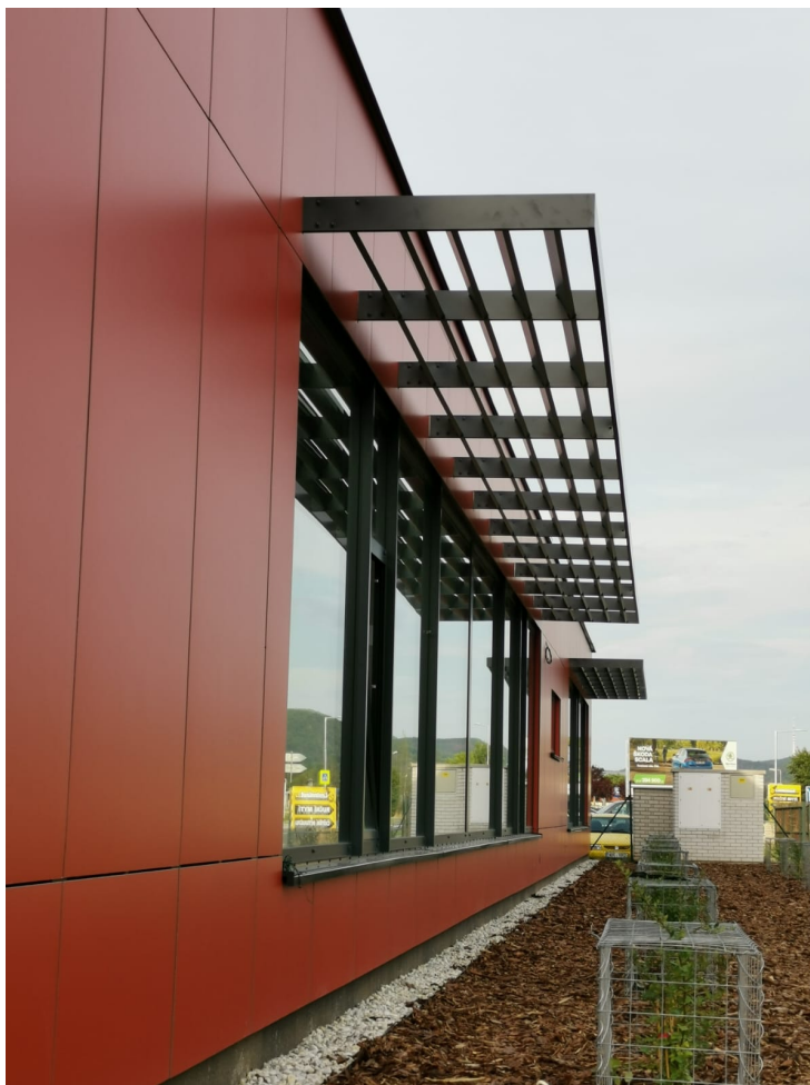
Obr. 13 – Hliníková konstrukce slunolamu na provětrávané fasádě
