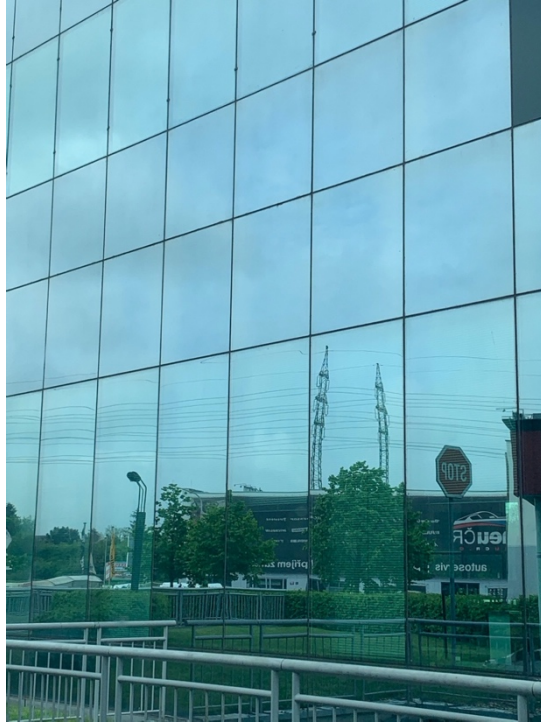
Obr. 11 – Pohled na strukturovaný lehký obvodový plášť
