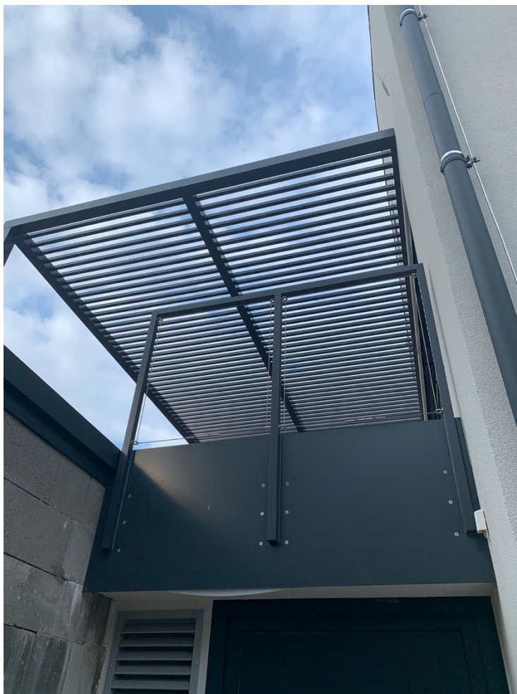
Obr. 14 – Hliníková pergola se statickými lamelami
