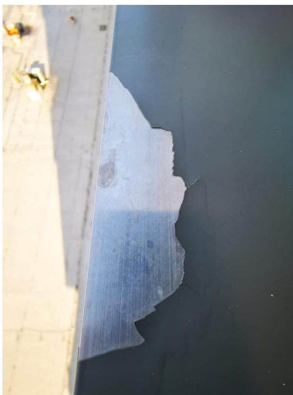
Obr. 28 – Detail na odlupující se práškový lak po špatném odmaštění
