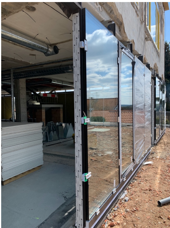
Obr. 20 – Detail osazení skleněné tabule na nosný sloupek
