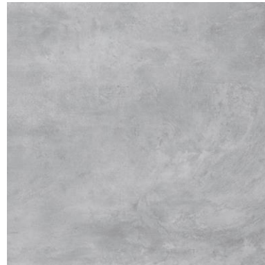
Betonová stěrka podlahy
