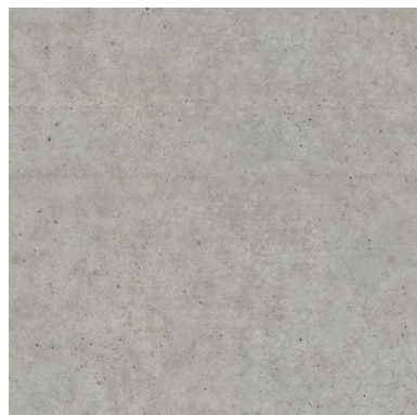
pohledový beton krystalický nátěr lodžie
