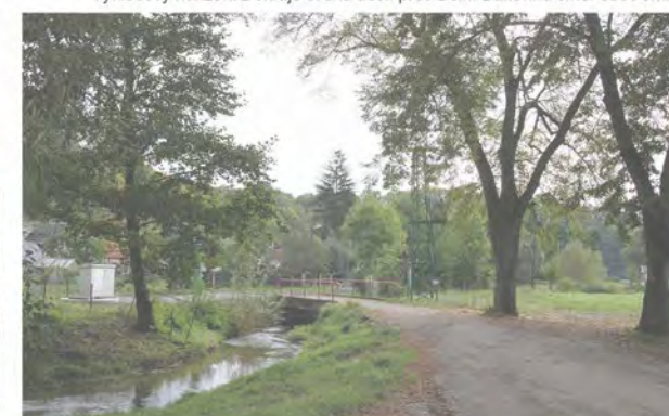
Pohled na mostek přes říčku Zábrdku v obci Dolní Bukovina
