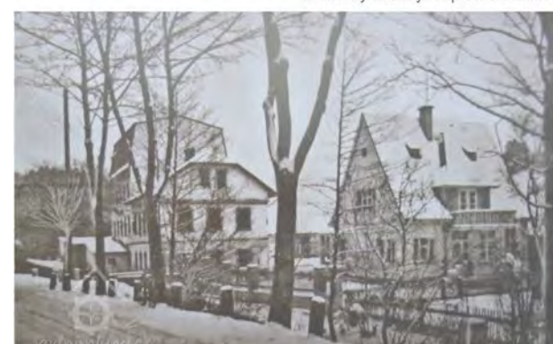
Stav 1. pol. 20. stol. - pohled ze silnice
