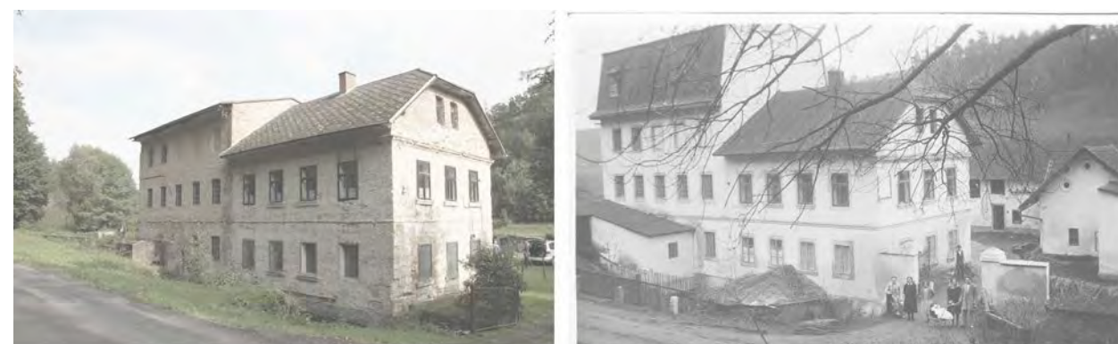
Současný stav mlýnu - pohled ze silnice
