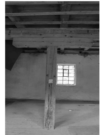
DŘEVĚNÁ KONSTRUKCE MLÝNICE
