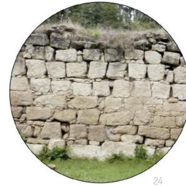
OBKLAD Z PŮVODNÍCH PÍSKOVCOVÝCH BLOKŮ Z ROZVALIN
