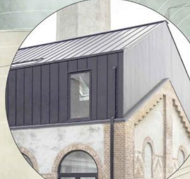
David Thulstrup - transformace staré budovy v Kodani na hotel
