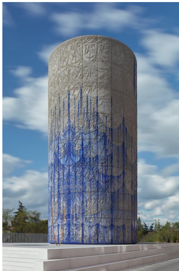
Obr. 9: Výdech tunelu Blanka v ulici Nad Královskou oborou obložený obkladovými prvky vyrobenými pomocí robotické ruky [42]
