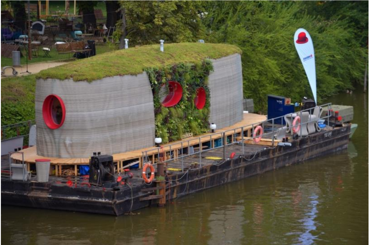
Obr. 13: První český 3D dům-Prvok umístěný na pontonu na Vltavě. [52]
