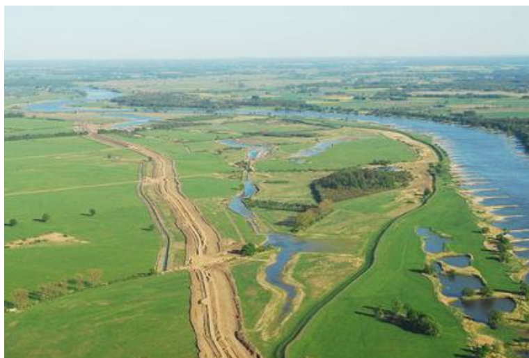
Obr. 3 - Přírodě blízké protipovodňové opatření (ochranná hráz posunuta od toku a území zanecháno jako přírodní poldr), (Střední Čechy – ochrana přírody, 2021).
