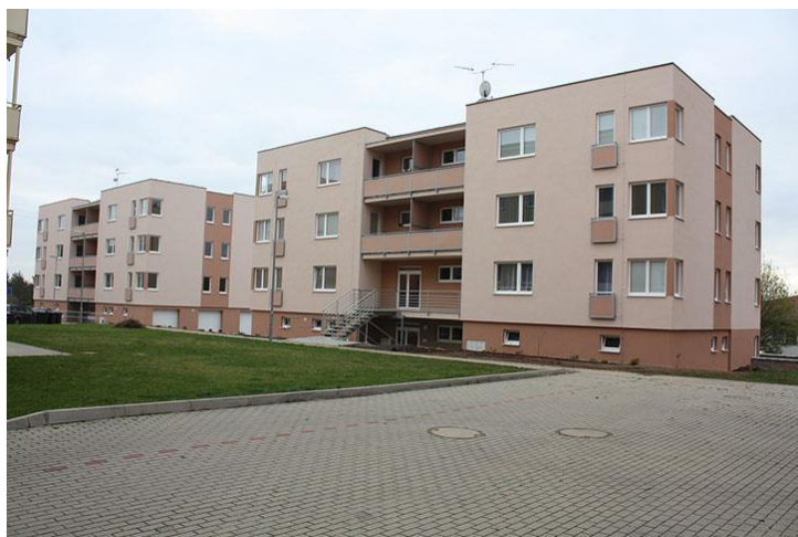
Obrázek 3 – Bytové domy, Rakovník
