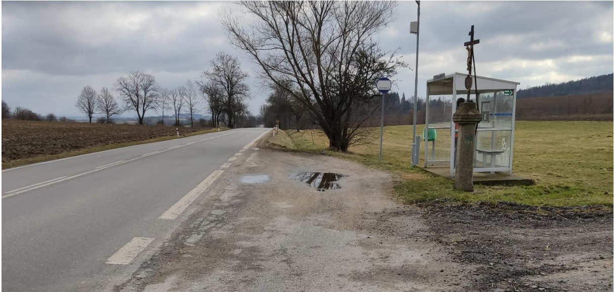
Obrázek 27 – „Drahonice, Albrechtice“ - směr staničení
