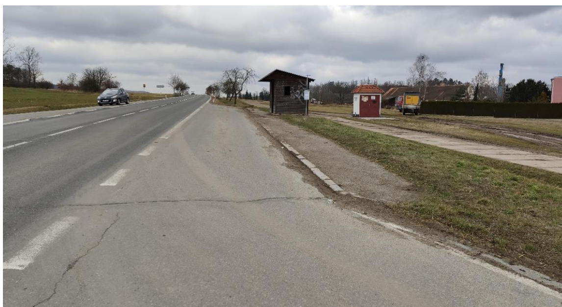
Obrázek 34 – „Vodňany, Křtětice“ - směr proti staničení
