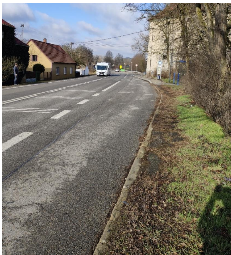
Obrázek 16 – „Strakonice, Střela“ - směr proti staničení
