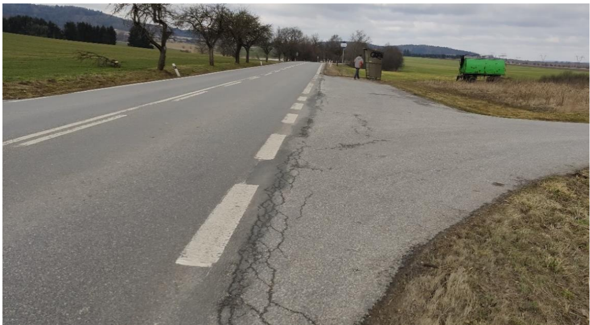
Obrázek 28 – „Drahonice, Albrechtice“ - směr proti staničení
