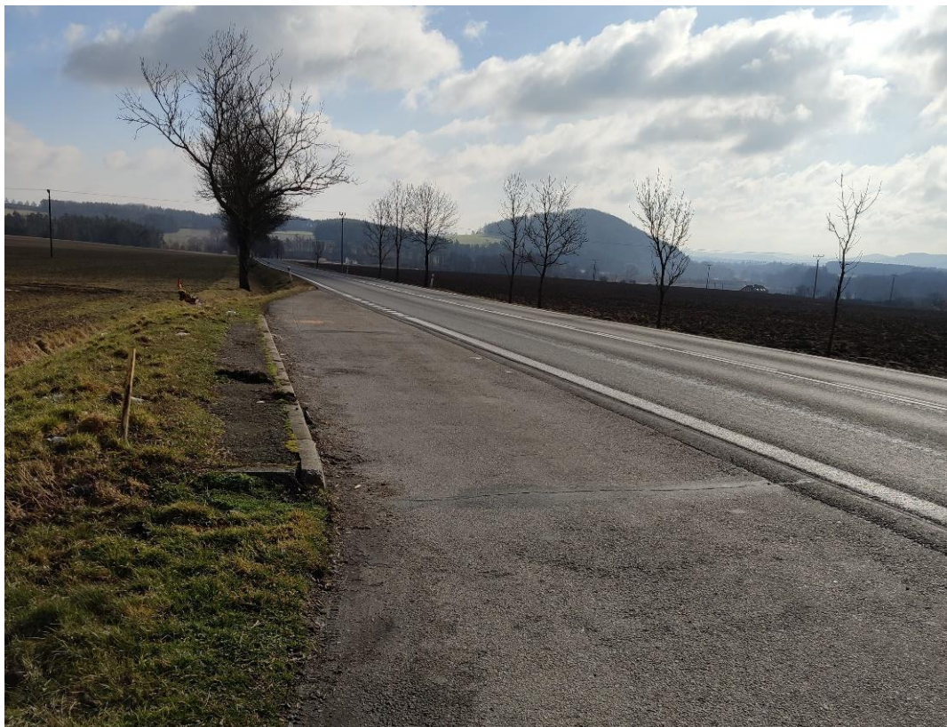
Obrázek 13 – „Horní Poříčí, Dolní Poříčí“ – směr proti staničení
