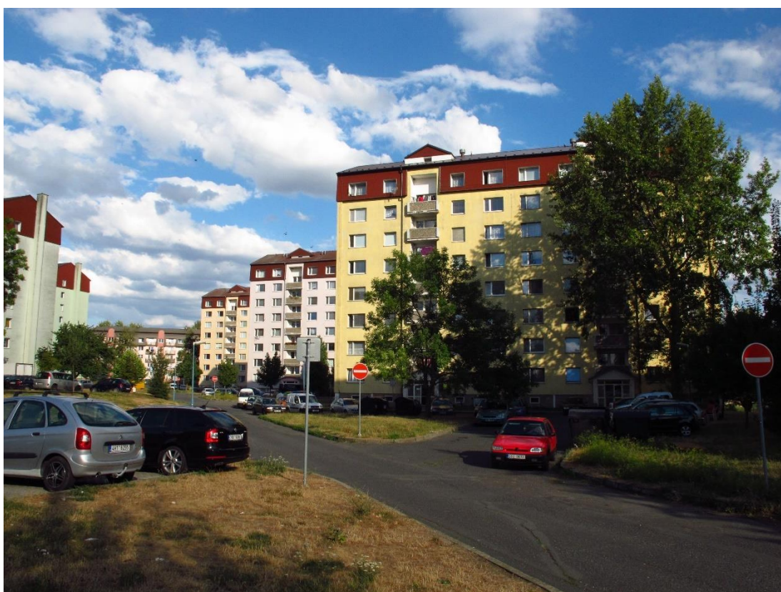
Obrázek 10 – Stávající stav bytových domů v Milovicích
