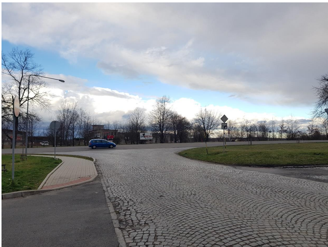
Obrázek 36 – Křižovatka Ostravská – Mírová, pohled z ulice Mírová
